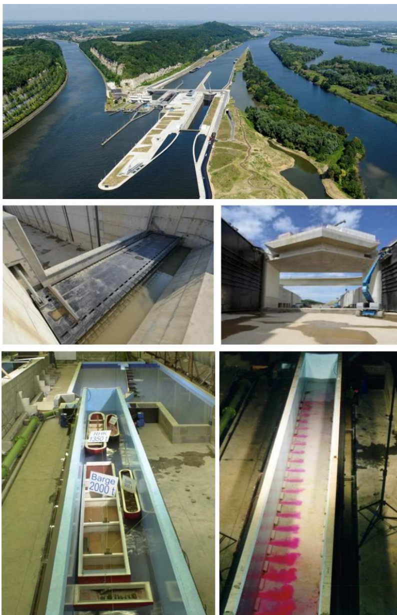
Slika 10.4: Prevodnica Lanaj IV; odozgo na dole: dispozicija objekta između Albertovog kanala (levo) i reke Meze (Meuse, desno); uzvodna glava sa obarajućom ustavom mase 80 t i nizvodna glava sa dvokrilnom čeličnom kapijom mase 125 t; fizički model komore sa kombinacijom merodavnih plovila/sastava i vizuelizacija bočnog punjenja komore kroz 22 otvora u zidu [72, 108].
