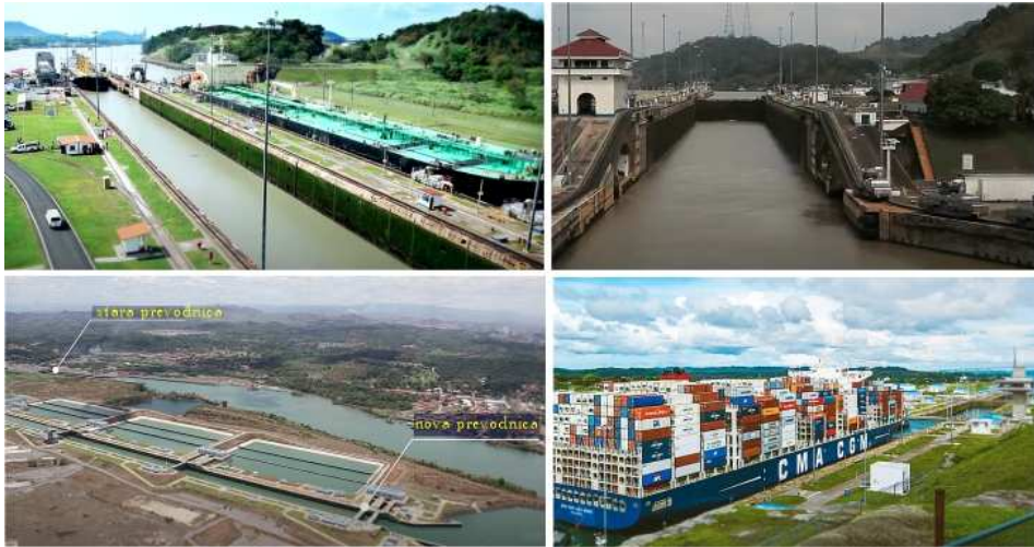
Slika 7.16: Prevodnice na Panamskom kanalu; gore: stare prevodnice; dole: nove prevodnice sa bazenima za uštedu vode i brod za prevoz kontejnera [118].
