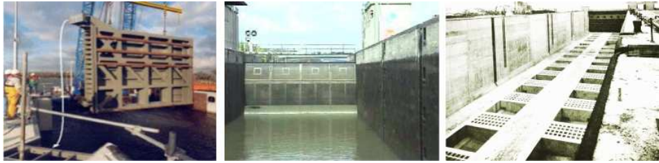
Slika 1.9: Primeri komora sa različitim hidrauličkim sistemima; sleva udesno: kapija sa otvorima pri dnu kroz koje se voda upušta u komoru [16]; ustava čije pomeranje (ili rotiranje) omogućava dotok u komoru; podeoni sistem sa galerijama i otvorima na dnu komore kroz koje se ova puni i prazni [39, 61].
