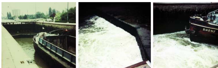
Slika 3.7: Uticaj izlaznog mlaza iz galerija, smeštenih ispod praga [39].
