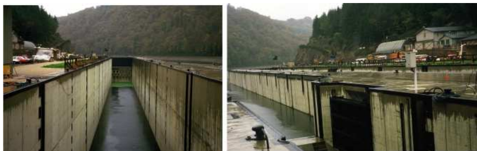
Slika 1.7: Prevodnica Serig (Serrig) na reci Sar (Saar) u Nemačkoj; levo: mala komora; desno: velika komora [39].
