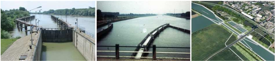
Slika 1.13: Primeri usmeravajućih građevina; sleva udesno: prevodnica u sklopu brane na Tisi [39]; prevodnica na plovnom kanalu Rajna-Majna-Dunav [39]; prevodnica na projektovanom kanalu Sena Severna Evropa (Canal Seine Nord Europe) [72].
