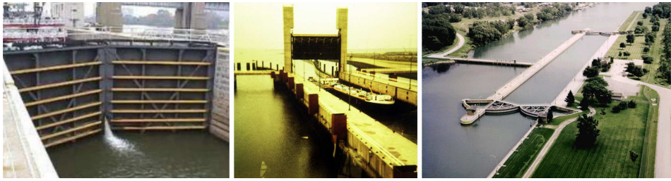
Slika 1.8: Tipovi kapija; sleva udesno: dvokrilna tablasta kapija [16], podizuća ustava [39], dvokrilna segmentna kapija [39].
