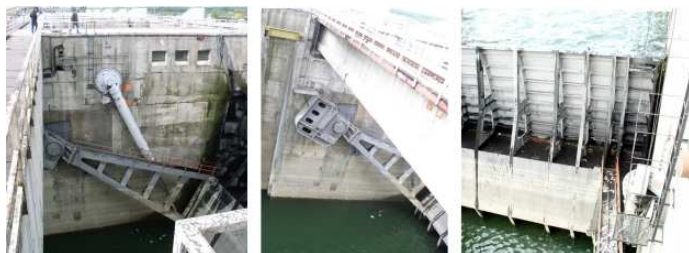
Slika 6.5: Segmentne ustave na brani HEPS „Đerdap II” [39].
