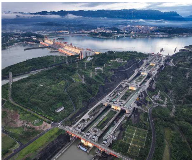
Slika 1.6: Stepenasti sistem paralelnih prevodnica kod brane „Tri klisure” na reci Jangcekjang u Kini [111].
