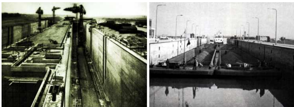
Slika 1.5: Komora brodske prevodnice u izgradnji i u periodu eksploatacije [48].
