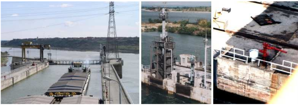
Slika 1.12: Prevodnica u sklopu brane „Đerdap II” (pad 12,5 m) omogućava jednovremeno prevođenje 10 plovila sa gazom do 5 m, ukupne nosivosti do 14000 t; sleva udesno: komora dimenzija 340 m × 34 m; ulaz u komoru sa signalnim tornjem i uređajima; aparat za gašenje požara crvene boje [39].
