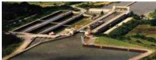
Slika 1.14: Primer bazena za uštedu vode (prevodnica Uelzen I na plovnom putu reka Elba – Kanal Seiten, Nemačka) [72].
