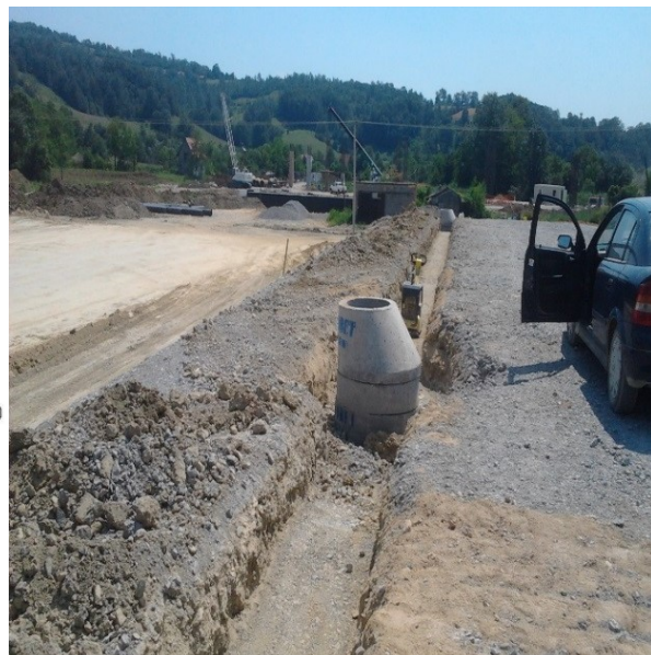
Slika 6. Ugradnja kanalizacije i drenaže u razdelnom pojasu – detalji sa izvođenja
