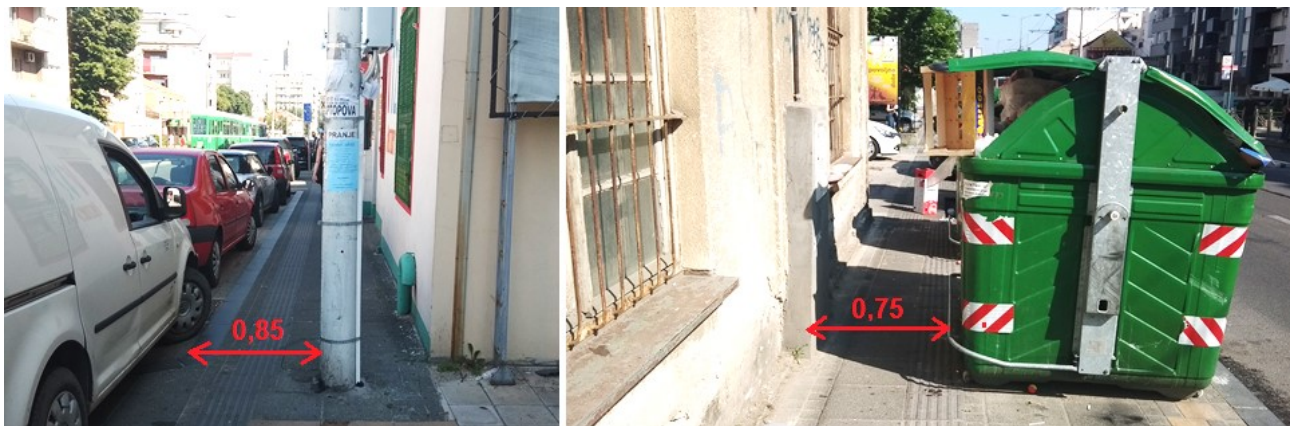
Slika 10. Nedovoljna širina pešačkih staza, Ulica vojvode Stepe (rekonstruisana 2015.)
