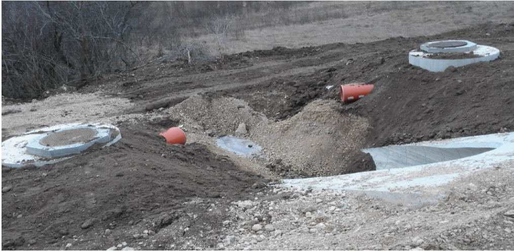
Slika 19. Na auto putu E-80 je dat detalj izliva iz dva separtora i cevastog propusta
