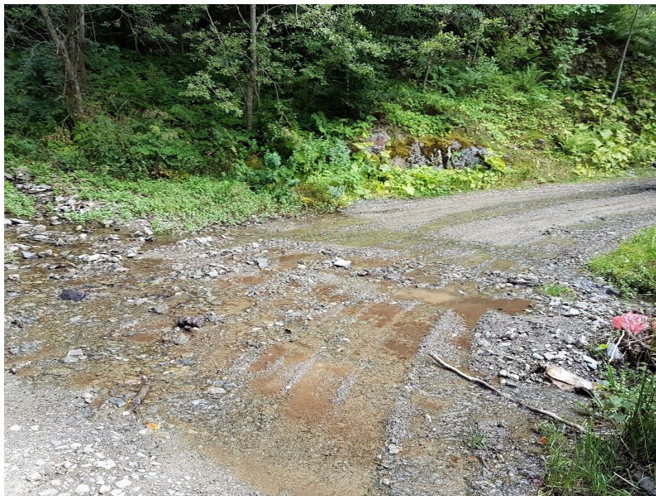
Slika 2. Ukrštanje šumskog puta (bez propusta) sa vodotokom (putni pravac „Ribnja bara - Javor“; X=7651650.53, Y=4791094.80)
