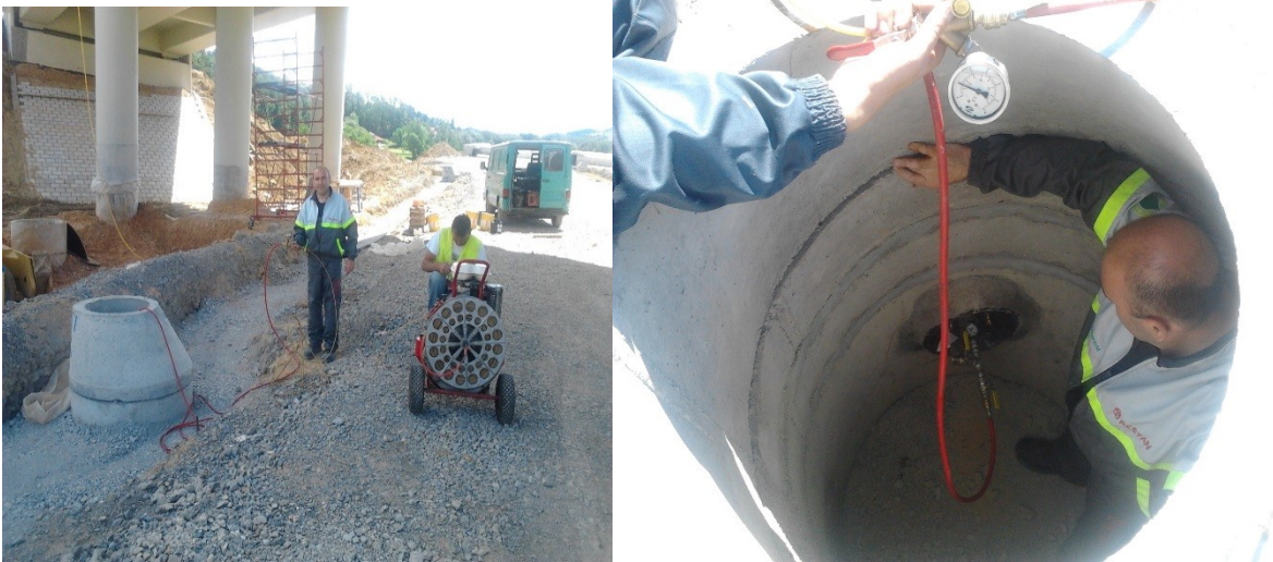
Slika 5. Ispitivanje kanalizacionih cevi sa vazduhom
