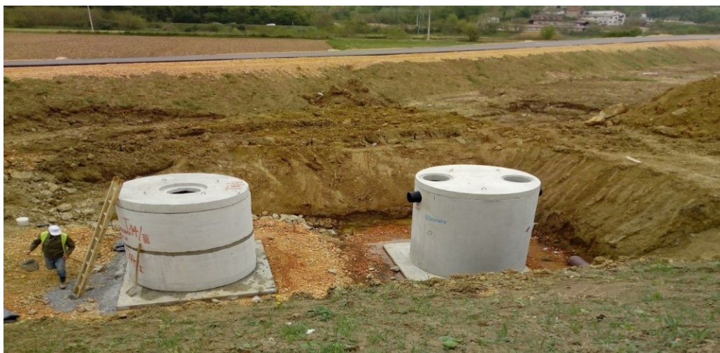
Slika 14. Na deonici E 763 Lajkovac - Ljig postavljanje betonskog separatora sa taložnikom
