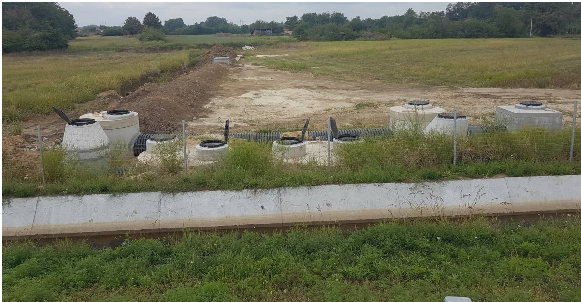
Slika 12. Separator sa eksternim bajpasom Q=130/1000 l/s
