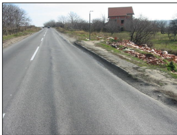
Слика 3. Изглед оштећења: лево - мрежасте пукотине типа крокодилске коже и улегнућа, државни пут IB реда бр. 39, деоница Власотинце - Свође, снимљено 2005.године; десно – колотрази, државни пут IIA реда бр.154 до изградње Обилазнице Београда, деоница Бубањ Поток- Бели Поток
