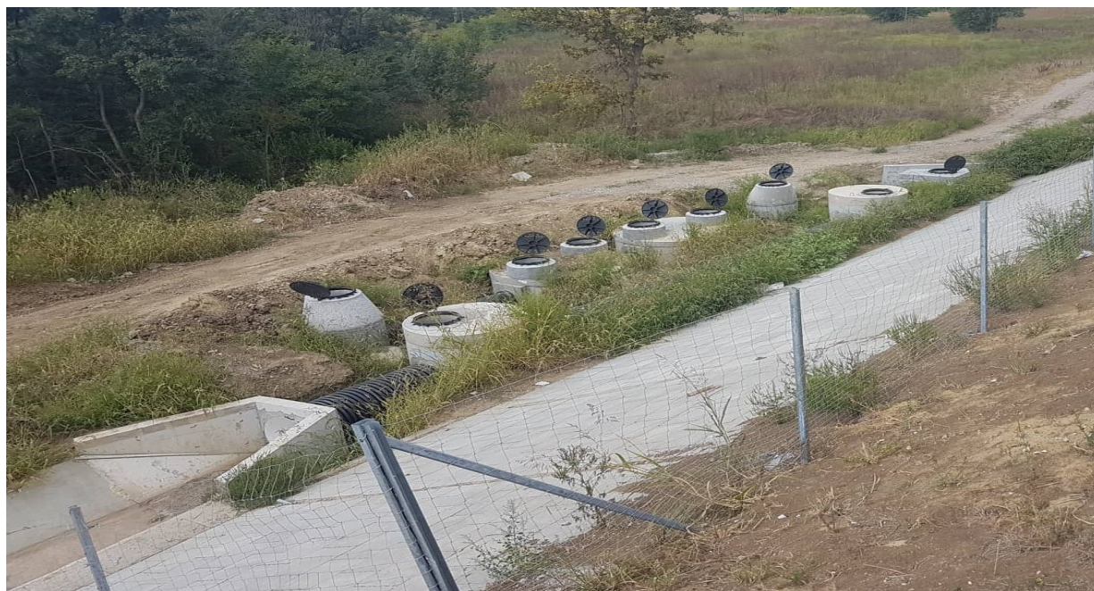
Slika 11. Separator sa eksternim bajpasom Q=80/400 l/s
