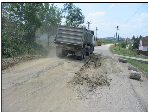
Слика 3. Изглед оштећења: лево - мрежасте пукотине типа крокодилске коже и улегнућа, државни пут IB реда бр. 39, деоница Власотинце - Свође, снимљено 2005.године; десно – колотрази, државни пут IIA реда бр.154 до изградње Обилазнице Београда, деоница Бубањ Поток- Бели Поток
