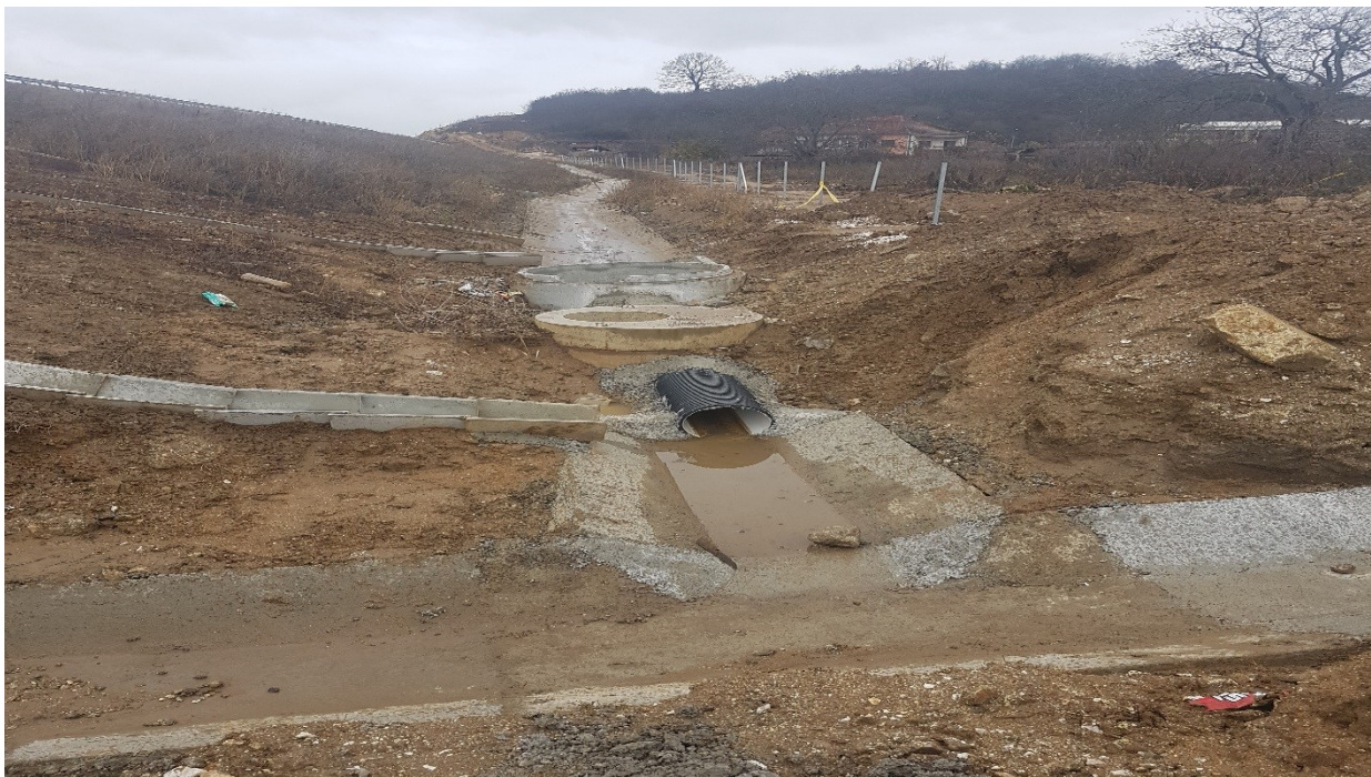
Slika 24. Problem sa zatrpavanjem separatora materijalom sa nasipa
