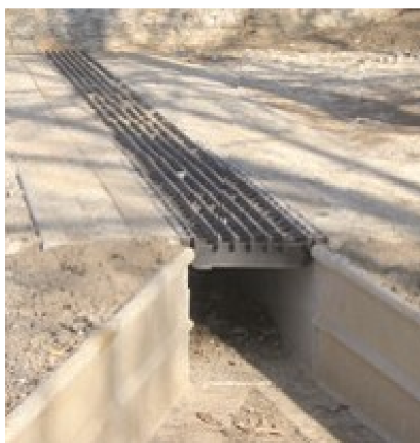
Slika 18. IZVEDENI PROLAZ KOMBINOVAN OD POLIMER BETONSKIH I CEMENT BETONSKIH ELEMENATA Izvor: (www.aco.rs)
