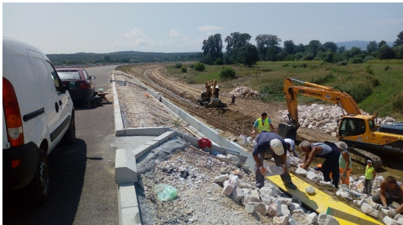
Slika 2. Izgled brzotoka – korube, sa detaljima
