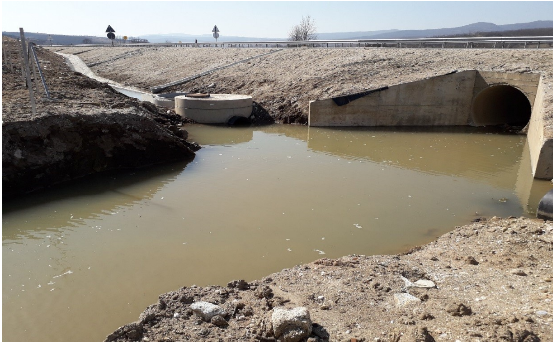
Slika 23 Deonica auto puta E 75, Srpska kuća - Levosoje, ima problema sa potopljenim izlivom - ispustom
