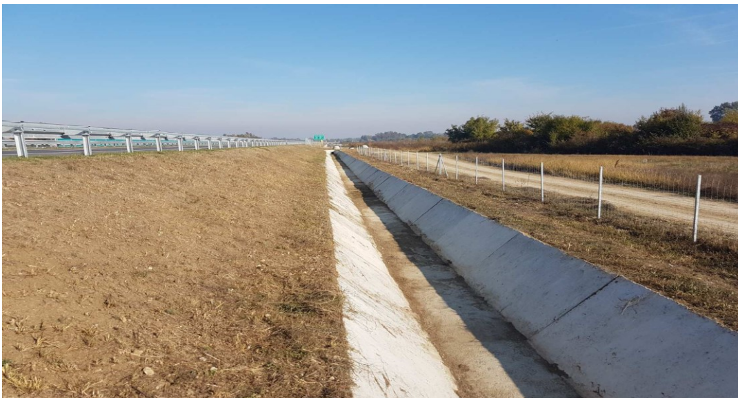
Slika 5. Primer Auto puta E 763 Obrenovac - Ub: Otvoreni betonski kanal
