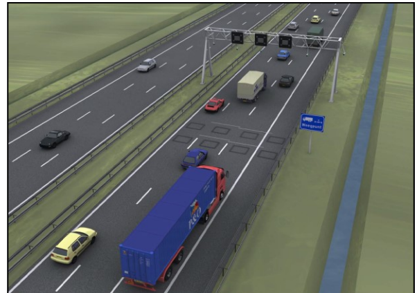
Слика 4. Изглед: лево - мерно место у коловозу; десно - портал на аутопуту [13]
