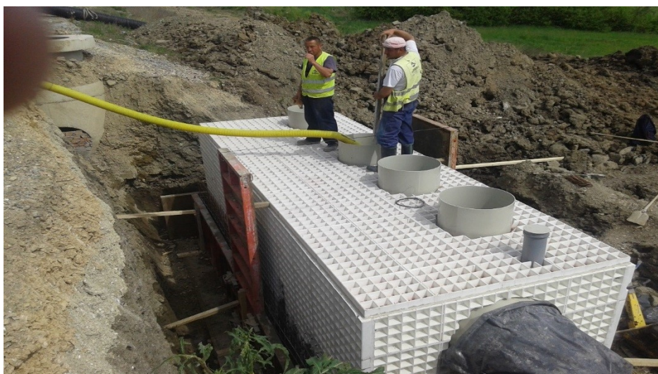
Slika 15. Postavljanje plastičnog i polietilenskog separatora na deonici E 763
