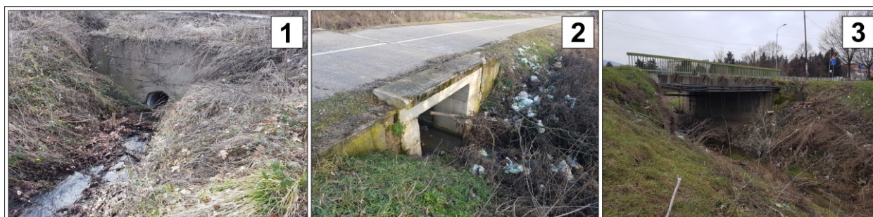
Slika 2. Različite dimenzije otvora putnih propusta i mostova
