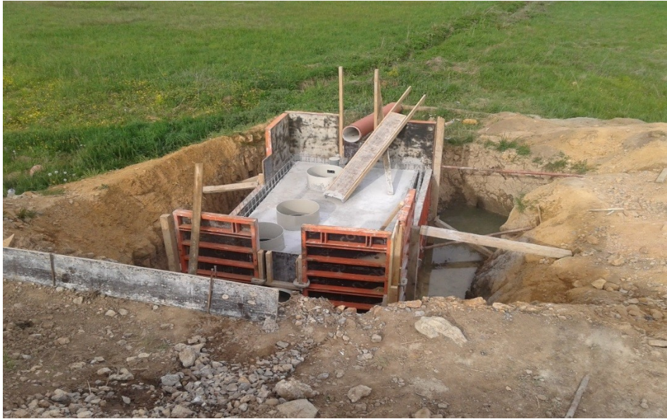
Slika 16. Ugradnja plastičnog separatora u podzemnoj vodi E-763
