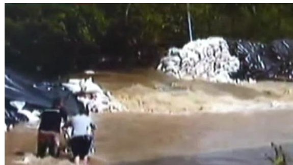
Слика 16. Пробој неправилно направљене баријере од цакова с песком и почетак поплаве града
