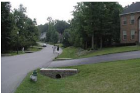
Slika 1. Primer izgleda jednog zatravnjenog kanala
