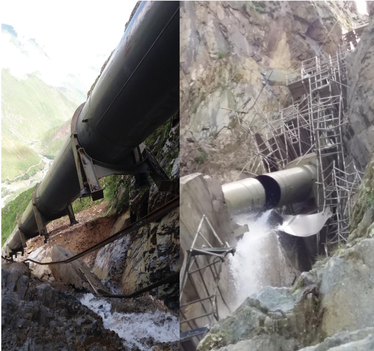
Slika 10. Ostećenja cevovoda
