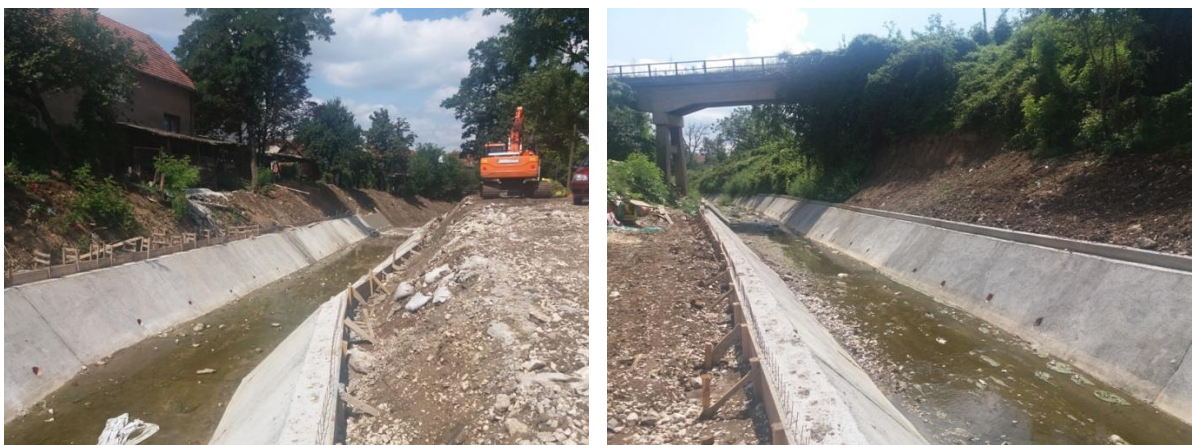
Slika 8. Radovi na uređenu korita Rokovog potoka i inspekcione staze.
