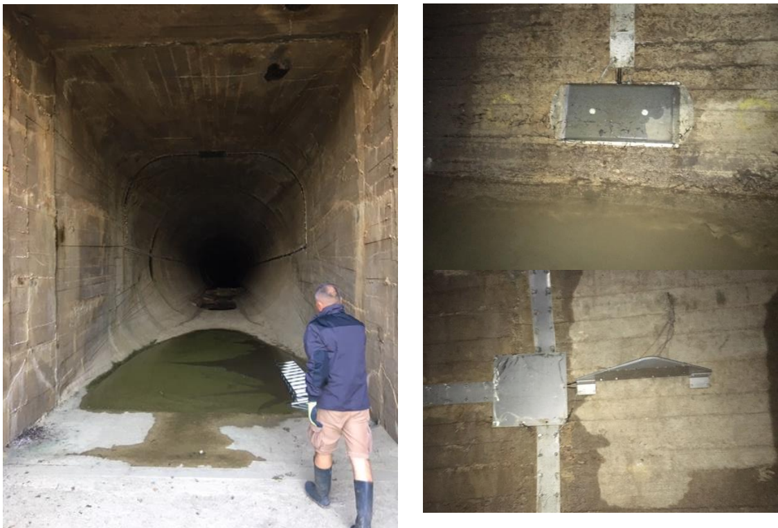
Slika 4. Merni sistemi u okviru derivacionog tunela Dabarsko polje – Fatničko polje: Izlazno/Ulazna građevina u Fatničkom Polju (Levo); Veliki ravni EM senzor u okviru osnovnog mernog sistema (Desno, gore); EM senzor „Ajkulino krilo“ u okviru kontrolnog mernog sistema (Desno, dole)
