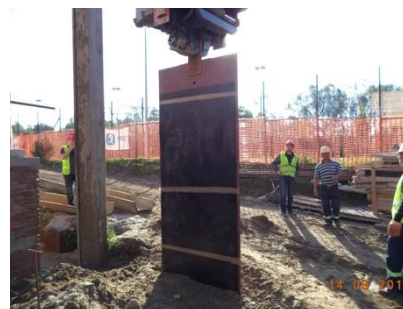
Слика 8. Побијање водонепропусних баријера у тло
