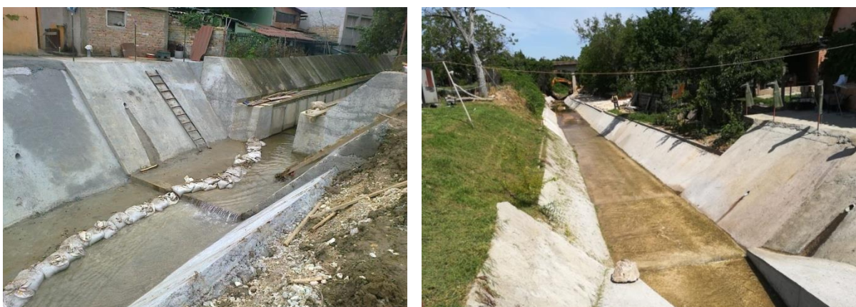
Slika 6. Radovi na izgradnji ulivne građevine.
