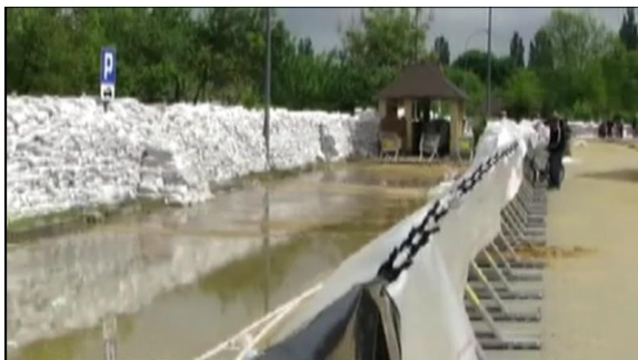
Слика 15. Пример неправилно урађене баријере од цакова с песком пошто је претходно постављена специјална мобилна баријера била недовољне висине
