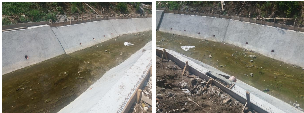
Slika 9. Radovi na uređenu korita Rokovog potoka.
