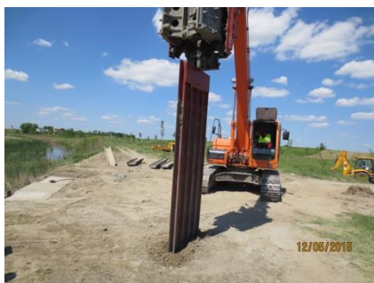
Слика 7. Побијање водонепропусних баријера у тло
