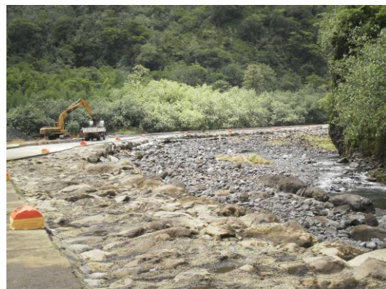
Pogled sa preлива ka recipijentu View from spillway to recipient
