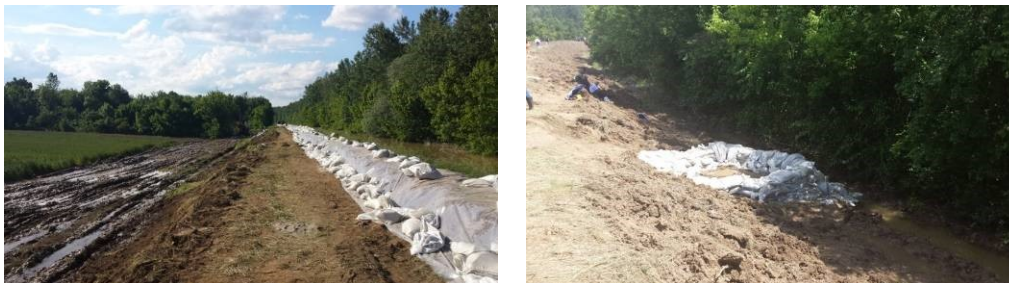
Слика 3. Надвишење насипа и каптирање извора (извор: ЈВП „Србијаводе“) Figure 3. Levee heightening and underseepage relief well (source: PVMC “Srbijavode”)
