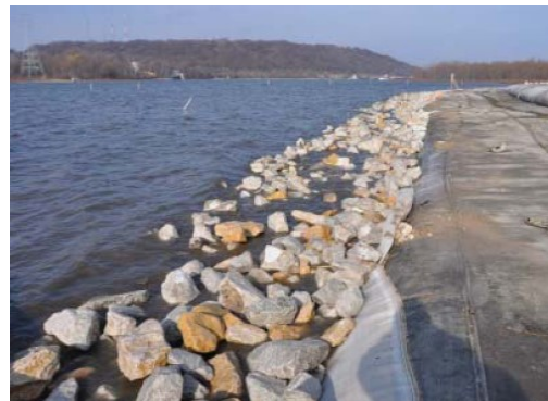
Слика 11. Заштита крупним ломљеним каменом Figure 11. Rock riprap
