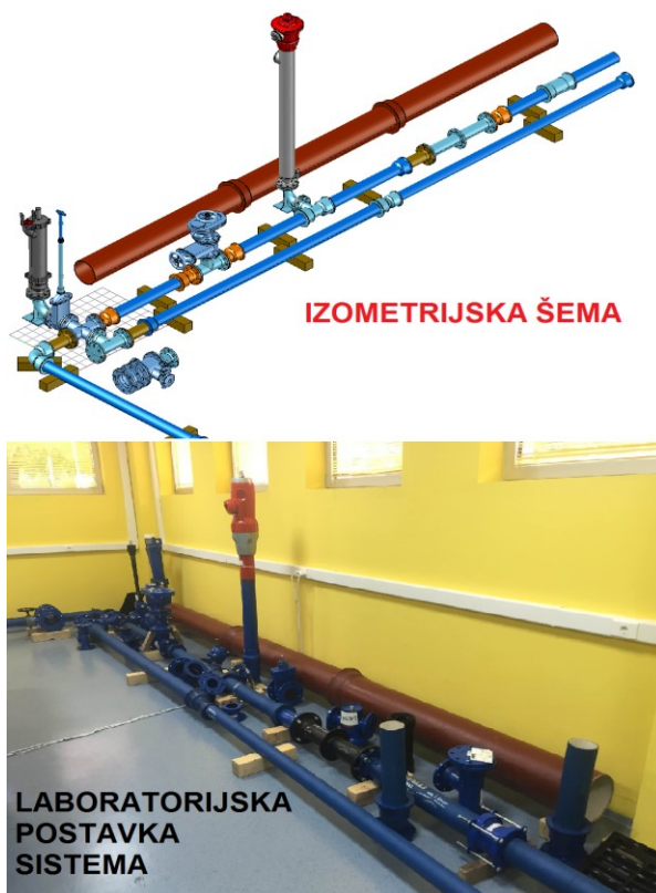
Slika 18. Instalacija cevovoda sa armaturom Figure 18. Pipeline instalation
