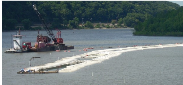
Слика 9. Пуњење елемената од геотекстила, који су постављени на пројектовану трасу Figure 9. Filling up of geotextile elements, aligned as designed
