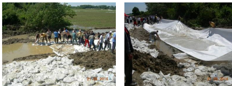
Слика 4. Заштита ножице насипа (извор: ЈВП „Србијаводе“) Figure 4. Levee foot protection (source: PVMC “Srbijavode”)
