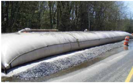
Слика 8. Изглед цевастог елемента од геотекстила (MacTube®) Figure 8. Geotextile tubular element (MacTube®)
