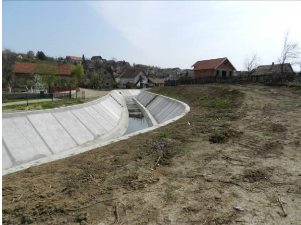
Слика 7. Армирано-бетонско корито Figure 7. Concrete channel
