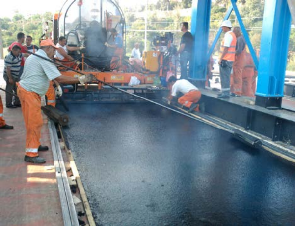
Slika 3. Finišer za liveni asfalt JKP „Beogradput“
