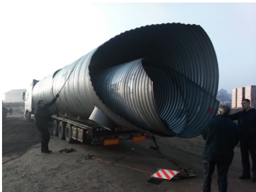
Slika 10. Specijalni transport i istovar čelične spiralne cijevi HC DN 3000, DN2200 i DN2000
