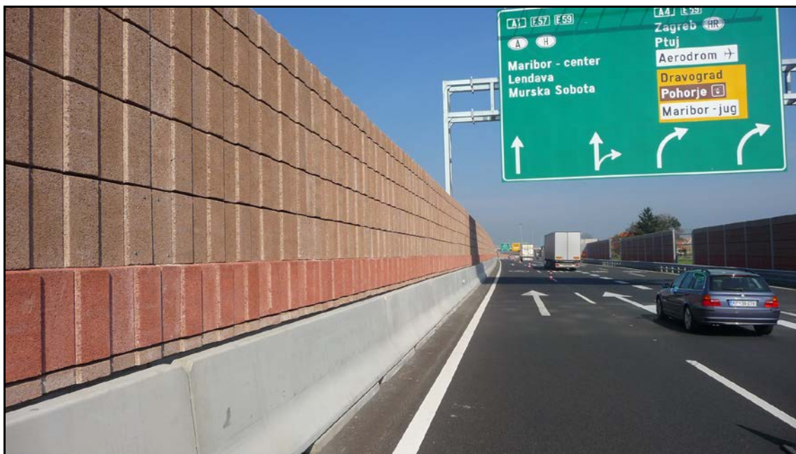
Slika 11: Ograda za zaštitu od buke na srednjoj traci autoputa A1 – Maribor Slovenija DB 100 LSW-M / H4b W5 sa, visina zida za zaštitu od buke 400cm Investitor: DARS (Družba za avtoceste v Republiki Sloveniji d.o.) Izvor: Arhiva Deltabloc
