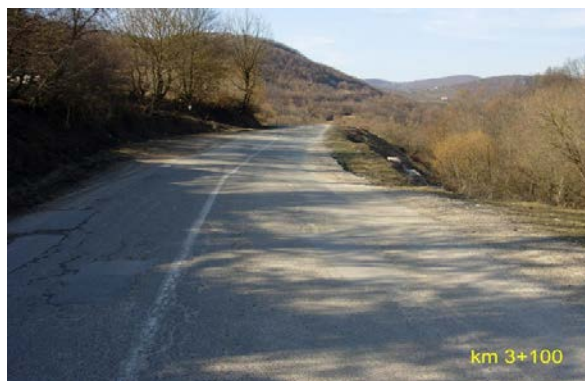
Slika 2. Nemogućnost vizuelnog sagledavanja toka trase Izvor: (arhiva AD "Novi Pazar – put")
