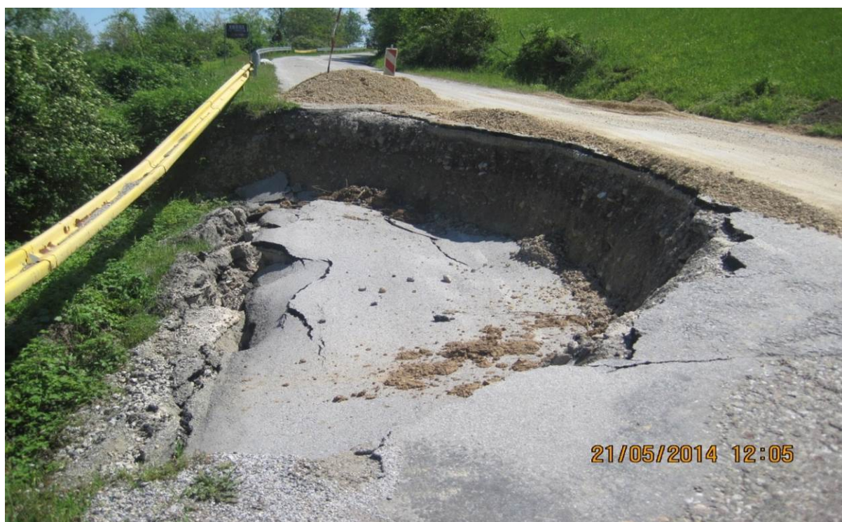
Слика 7 - Клизисте на државном путу IIA-170, деоница: Ваљево – Дебело брдо, кт:22+200, настало након мајских поплава 2014.год.
