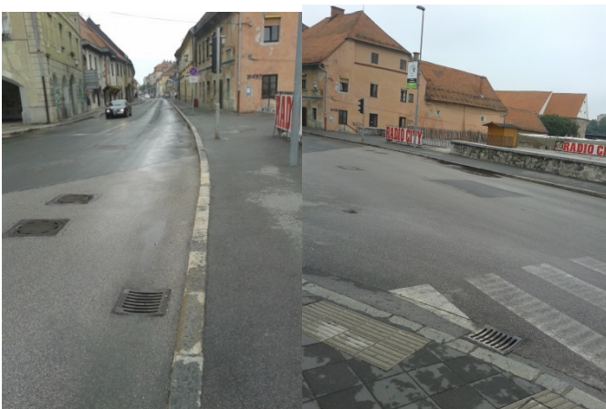
Slika 12: Odvodi uz ivičnjak trotoara Koroške ceste kod pijace u Mariboru
