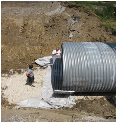
Slika 11. i 12. Montaža i spajanje čeličnih spiralnih cijevi sa spojnicama na HC DN3000 - Gunja;
