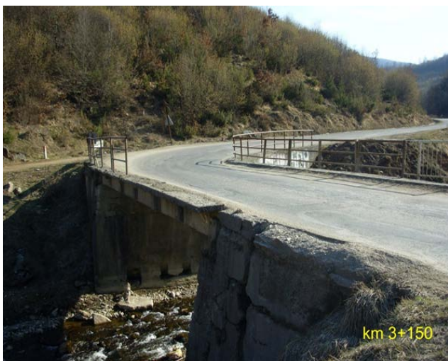
Slika 16. Zaštitna ograda na mostu ne postoji Izvor: (Arhiva AD "Novi Pazar – put")
