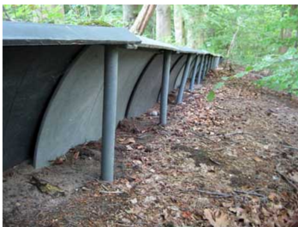
Slika 2. Plastične barijere sa spuštrenom ivicom za sitnije gmizivce i vodozemce
