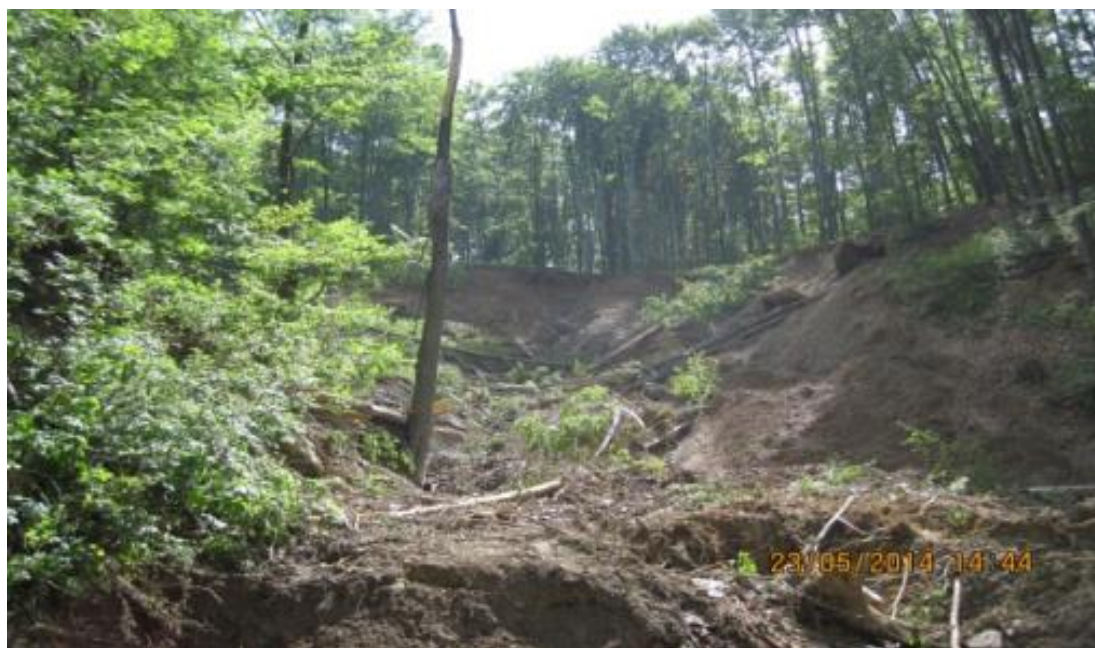
Слика 5 – Клизиште на државном путу IIА-139, деоница: Костајник –Столице, km:10+950 -11+070. Клижењем и бујичним разарањем захваћена је падина непосредно изнад и испод пута у дужини по путу од око 120m а уз падину преко 200m.
