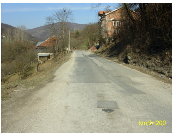
Slika 5. Loše stanje kolovoza, trasa u zaseku Izvor: (arhiva AD "Novi Pazar – put")
