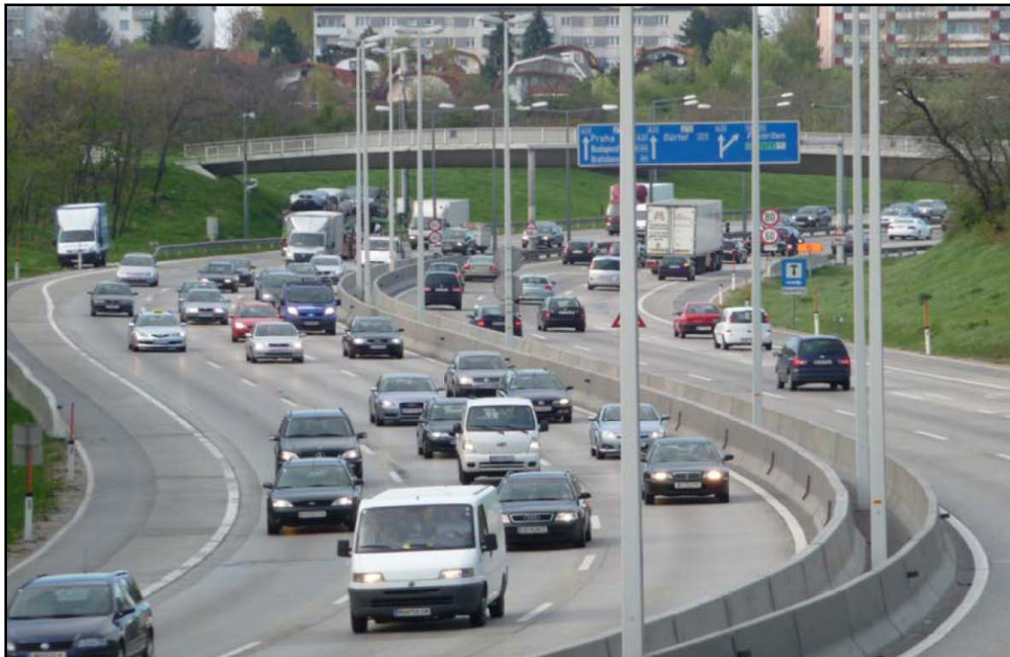
Slika 1: BZO montažna zaštitna H4b u srednjoj traci autoputa – dva reda Austrija Izvor: Arhiva Deltabloc
