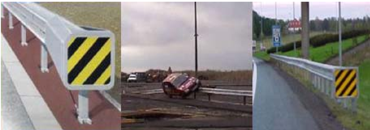
Slika 7. Završni terminali elastične zaštitne ograde
