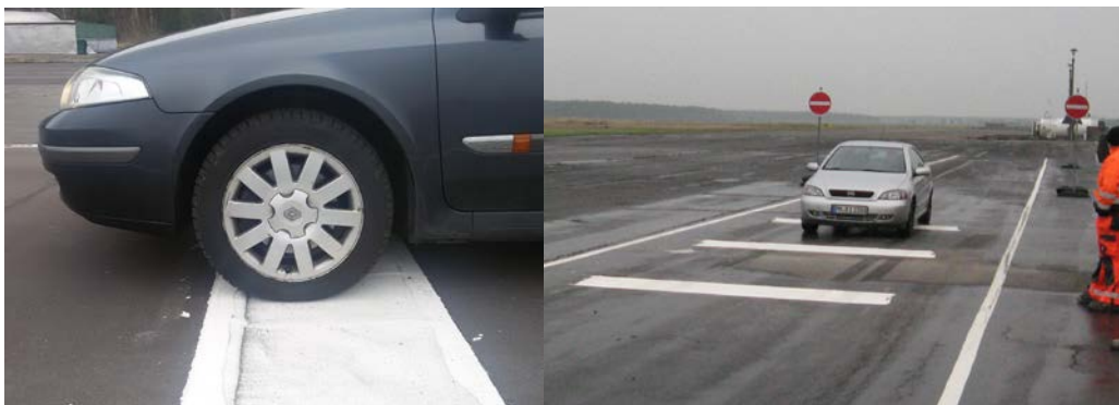
Slika 8. Trake za upozorenje zabranjenog pravca kretanja Izvor: www.evonik.com
