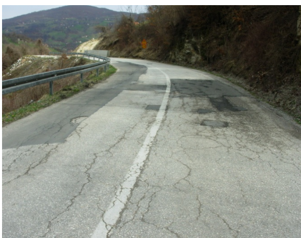
Slika 3. Loše stanje kolovoza Izvor: (arhiva AD "Novi Pazar – put")
