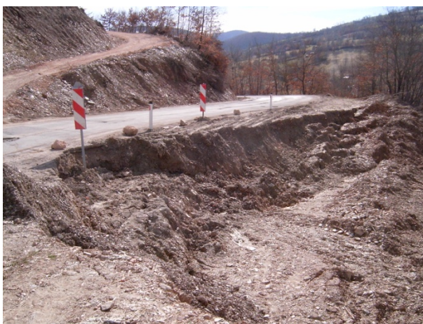
Slika 7. Aktivirano klizište 2007.godine Izvor: (Arhiva AD "Novi Pazar – put")
