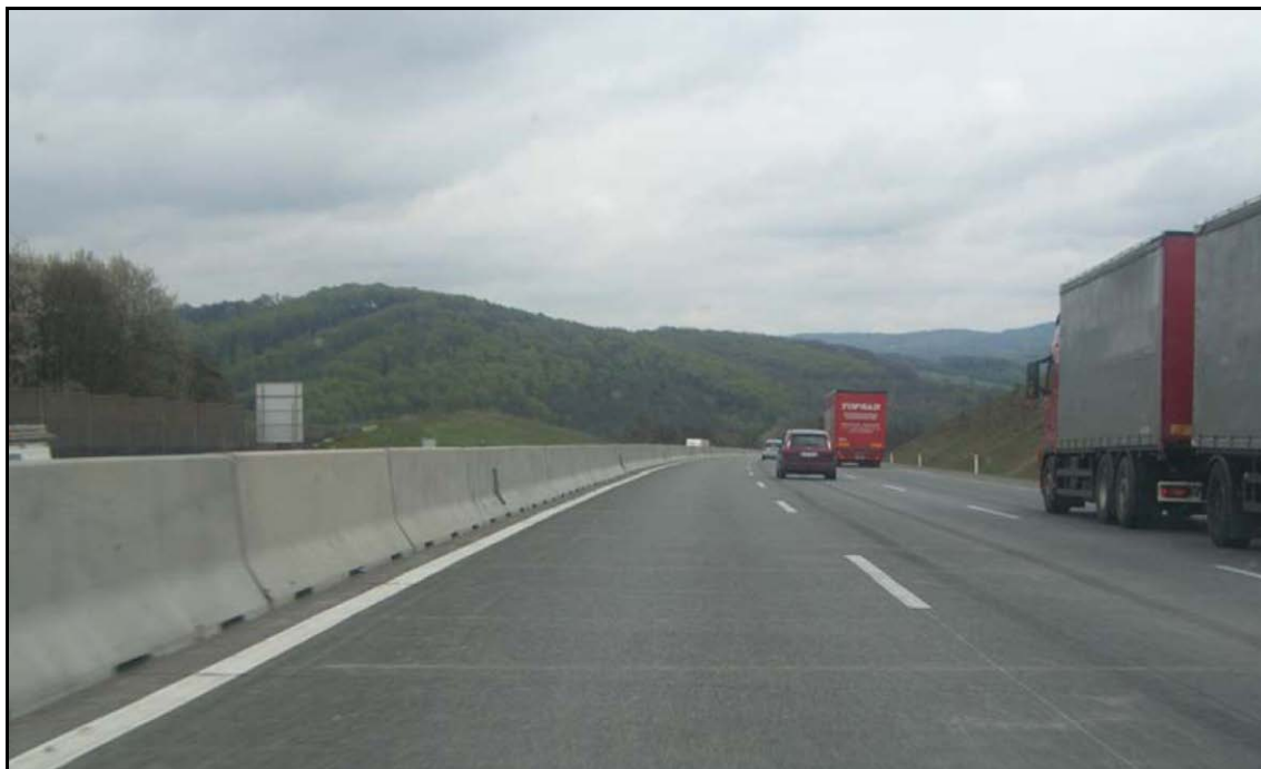
Slika 2: BZO - montažna nivo zaštite H4b u srednjoj traci autoputa – jedan red Izvor: Arhiva Deltabloc
