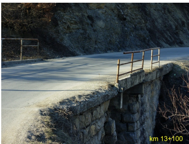
Slika 20. Zaštitne ograde gotovo da nema Izvor: (Arhiva AD "Novi Pazar – put")
