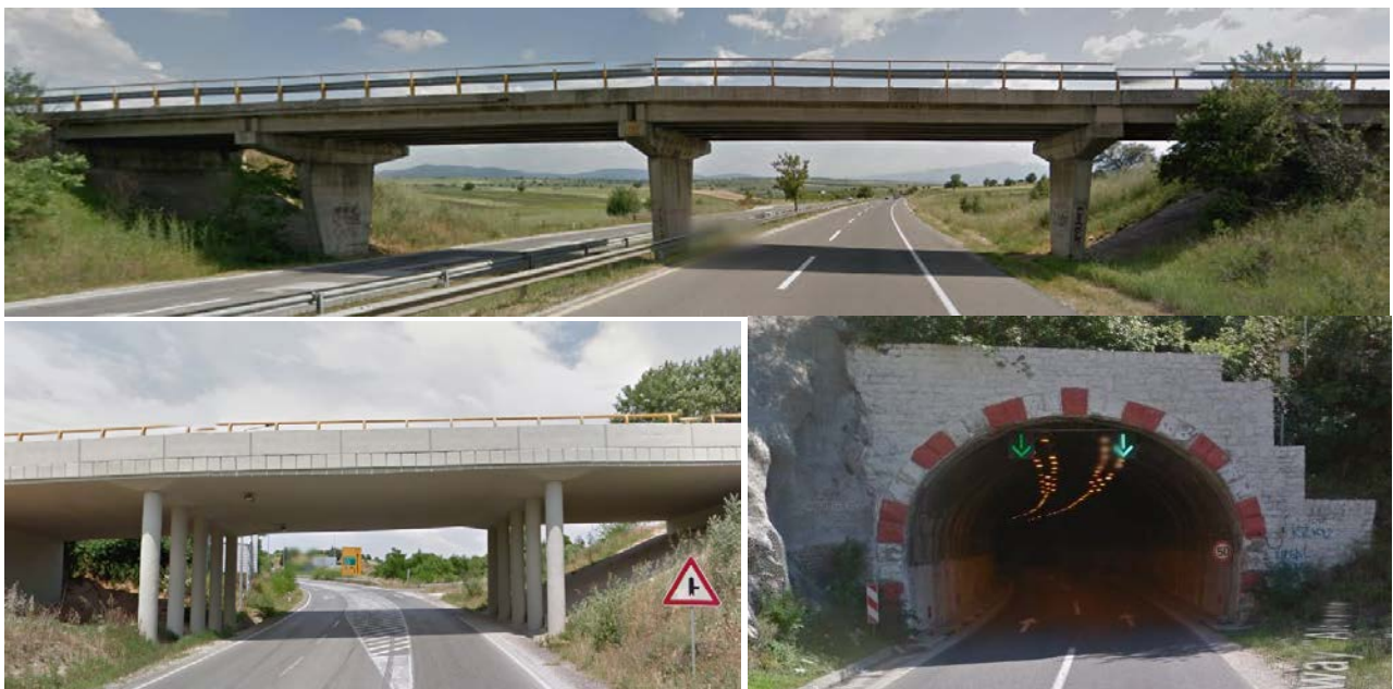
Slika 2. Nezaštićeni građevinski objekti na autoputu A1, deonica Kumanovo-Veles Izvor: Google Maps/Street view
