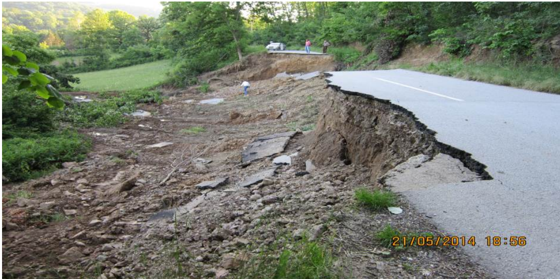
Слика 8 - Клизиште на путу IIA-150, кт:82+900, деоница: Босута-Белановица, Настало након мајских поплава 2014., дужине по путу 75m а низ падину око 60m,
