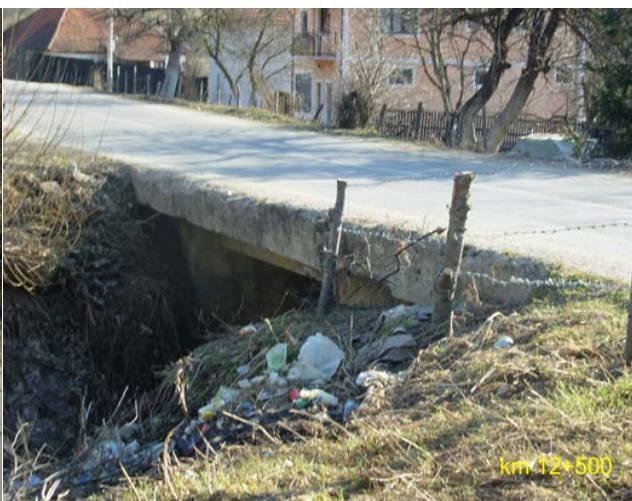
Slika 19. Zaštitna ograda na mostu ne postoji Izvor: (Arhiva AD "Novi Pazar – put")
