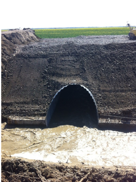
Slika 13. i 14. Zatrpavanje i zbijanje HC DN2200 i DN2000;
