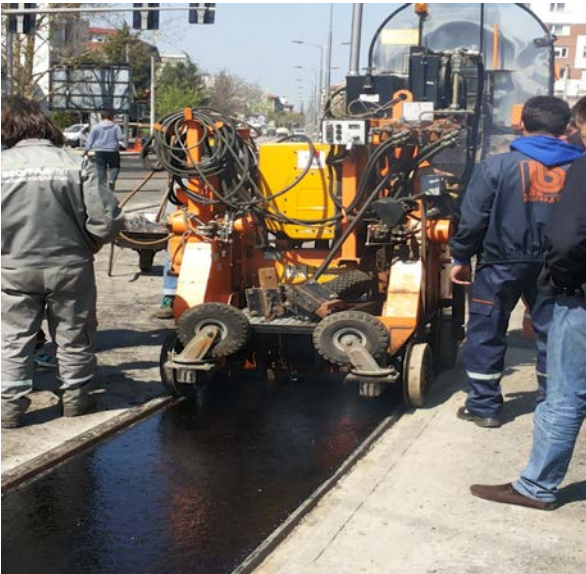
Slika 7. Izrada habajućeg sloja TLA 11 u ulici Vojvode Stepe u Beogradu 2015. god.
