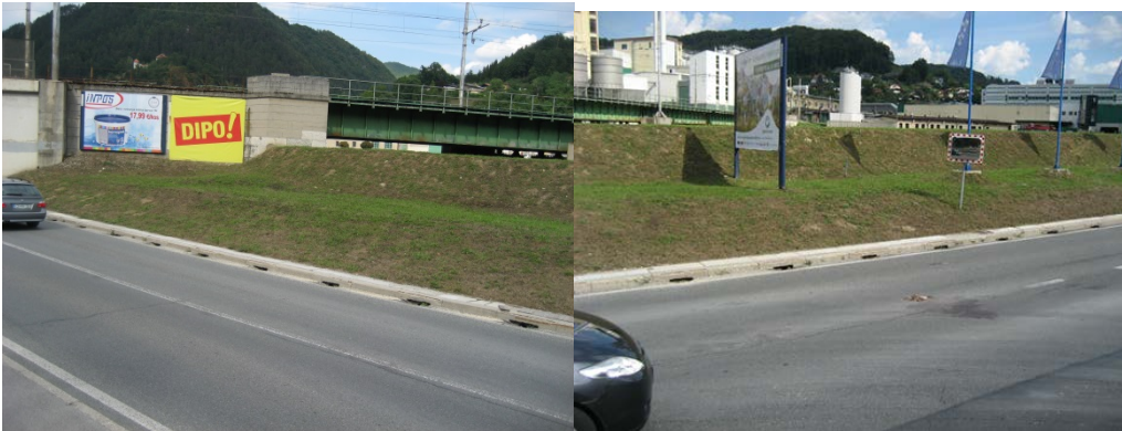
Slika 13: Odvodi uz ivičnjak kolovoza regionalnog puta Celje – Zidani most u Laškom
