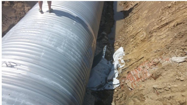
Slika 11. i 12. Montaža i spajanje čeličnih spiralnih cijevi sa spojnicama na HC DN3000 - Gunja;
