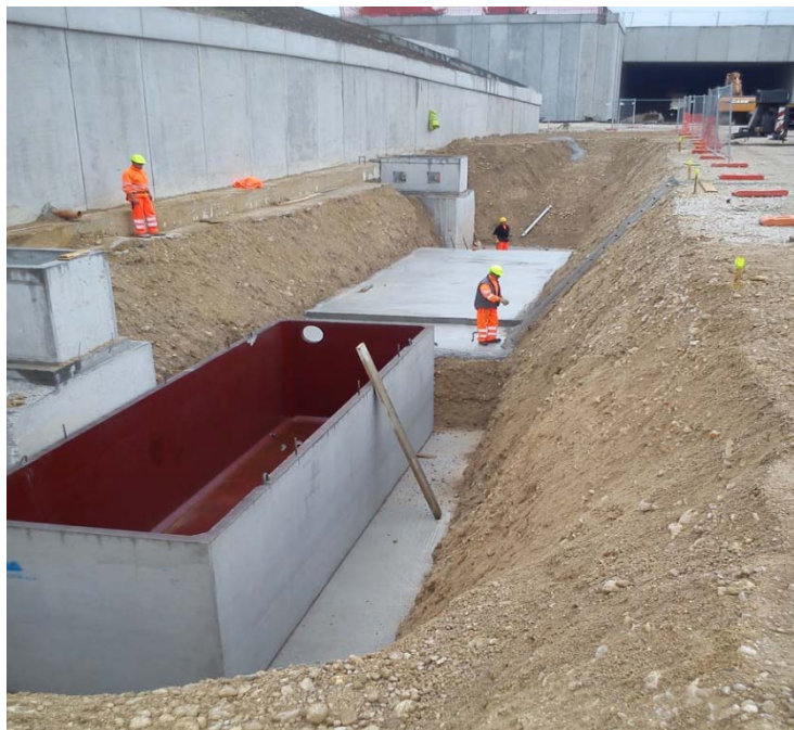
Slika 5. Objekat za trajno zadržavanje veoma zagađenog oticaja (impregniran crvenim premazom) i objekat za filtriranje oticaja (u drugom planu).
