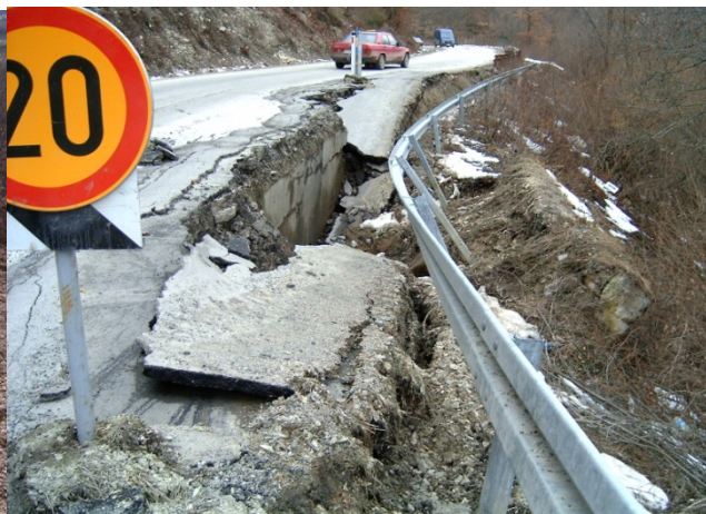
Slika 8. Aktivirano klizište 2007.godine Izvor: (Arhiva AD "Novi Pazar – put")
