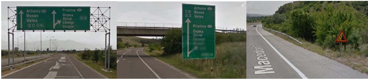
Slika 1. Nezaštićena saobraćajna signalizacija na autoputu A1, deonica Kumanovo-Skoplje Izvor: Google Maps/Street view
