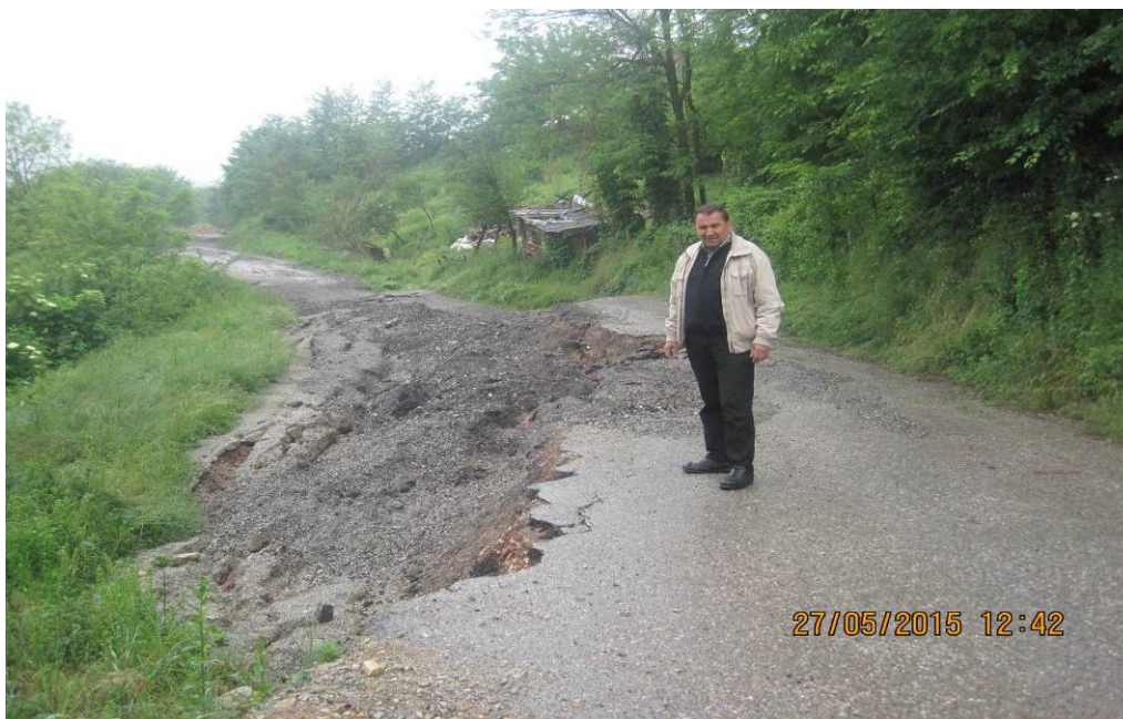
Слика 11 - Клизиште на државном путу: ИВ-342 Ваљево (Иверак) – Караула - Уб, кт: 3+610 у насељу Дупљај, настало као последица мајских поплава 2014. Клижењем је потпуно уништен пут у дужини од 100м и саобраћај је прекинут. Клижењем захваћена и падина изнад и испод пута са сеоским стамбеним објектима;
