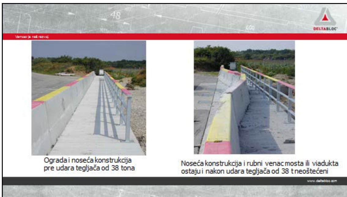
Slika 5: Ograda i noseća konstrukcija pre i posle udara tegljača od 38 tona Izvor: Kreš test arhiva Deltabloc
