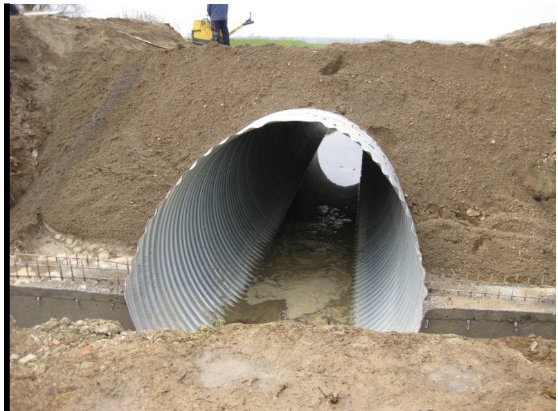
Slika 13. i 14. Zatrpavanje i zbijanje HC DN2200 i DN2000;
