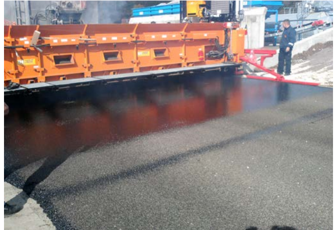
Slika 4. Finišer za liveni asfalt i posip od agregata JKP „Beogradput“
