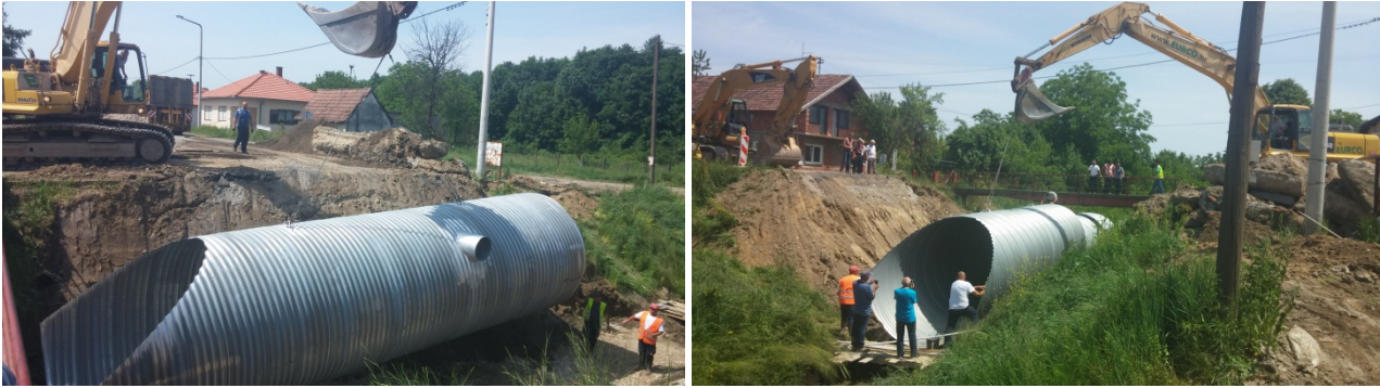
Slika 9. i 10. Polaganje i spajanje HC DN3000 na ranije pripremljenu podlogu;
