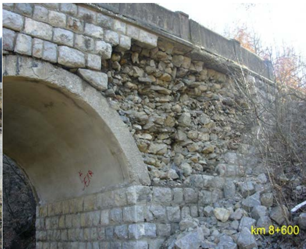
Slika 17 Oštećenje na spoljnom licu mosta Izvor: (Arhiva AD "Novi Pazar – put")
