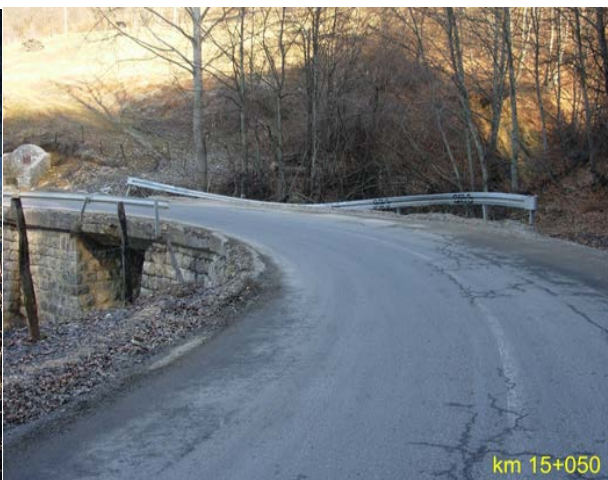
Slika 21. Zaštitna ograda na mostu je oštećena Izvor: (Arhiva AD "Novi Pazar – put")
