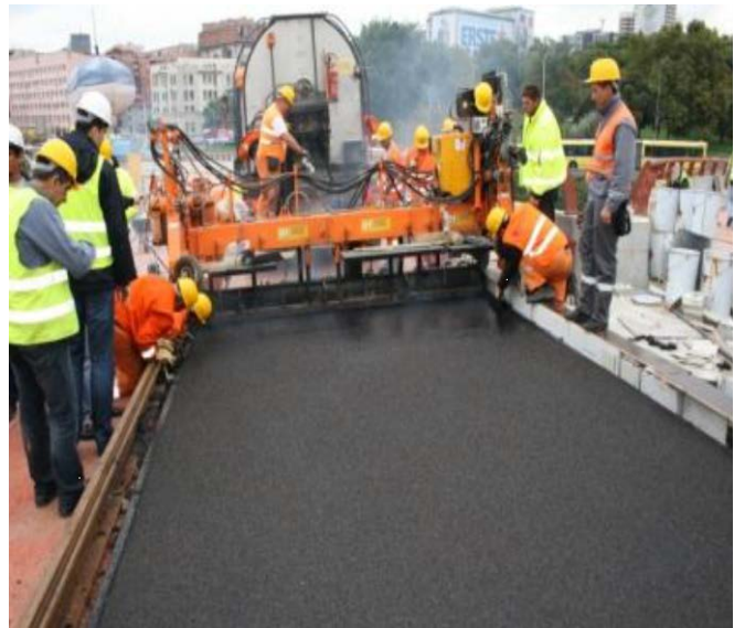
Slika 8. Izrada zaštitnog sloja TLA 11 na mostu „Gazela“ u Beogradu 2010. god.
