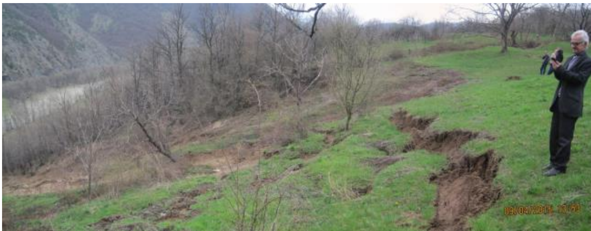
Слика 10 - Клизиште на државном путу IB-22, деоница: Краљево – Ушће, у месту Пивнице, кт:390+050, дужине око 350-400m x 200-250m x око 5-8m.
