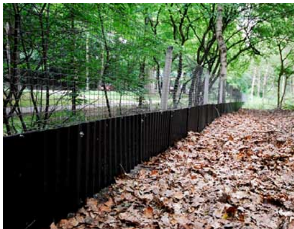
Slika 1. Žičana ograda sa plastičnim zastorom u donjem delu, za sprečavanje prolaza jazavaca
