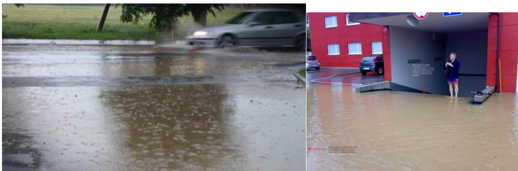
Slika 18: Poplave na novoizgrađenoj deonici Lackove ceste u Mariboru
