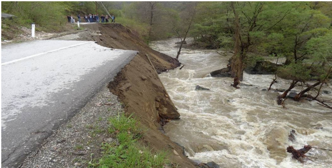
Слика 9 - Клизиште на државном путу IB-30, деоница: Ивањица-Ушће, кт:38+100; Дана 19.04.2014.године, у току веома обилних падавина, набујала река Студеница поткопала је и однела пут у целој ширини а у дужини од ~ 50m.
