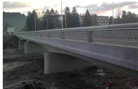
Slika 8. Izgled rekonstruisanog mosta
