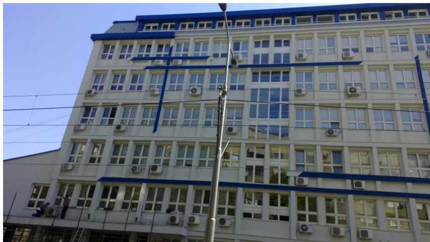
Slika 11- Rekonstrukcija i sanacija fasade objekta
