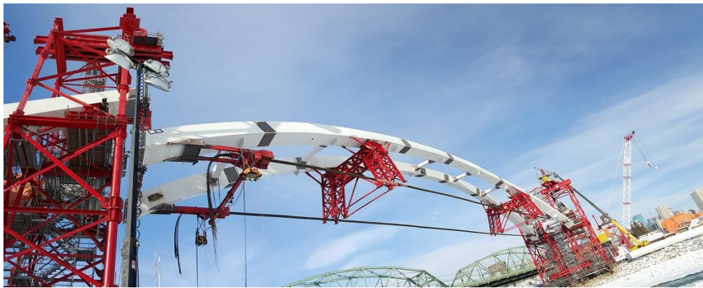
Sl.5.1 Montaža prvog 88.0 m lučnog segmenta (1000 t)
