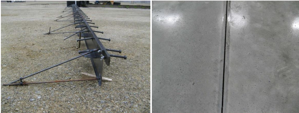
Slika 10 – Primeri instalacije oplatnog sistema i zvedene radne dilatacije na objektu Delhaize DC u Staroj Pazovi, 2014. god.
