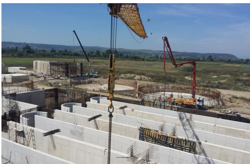
Slika 5 – Aeracioni bazen u fazi građenja.
