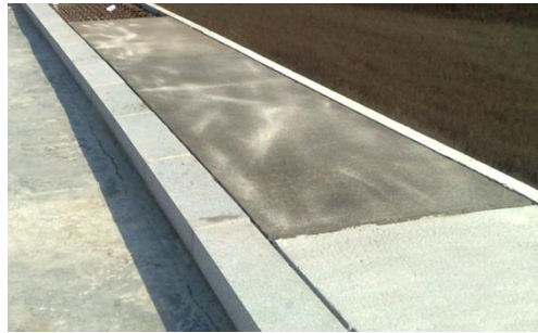
Obrada pešačke staze na mostu – sistem na bazi epoksida i metakrilata
