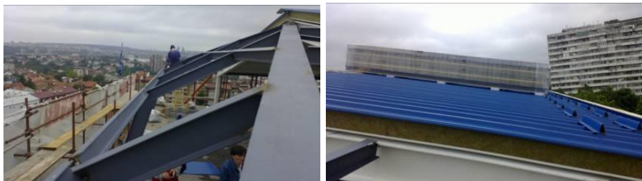
Slika 9- Montaža rožnjača i krovnog pokrivača
