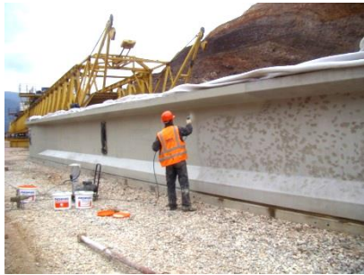
Zaštita mostovskog nosača oblaganjem - coating (Antikorozin-BB)
