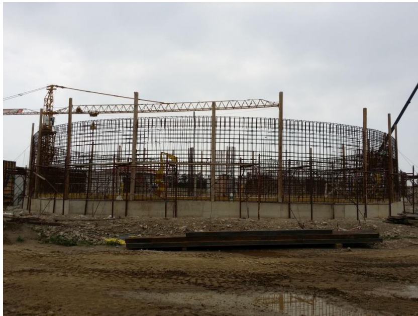
Slika 3 – Armatura zida kružnog rezervoara.
