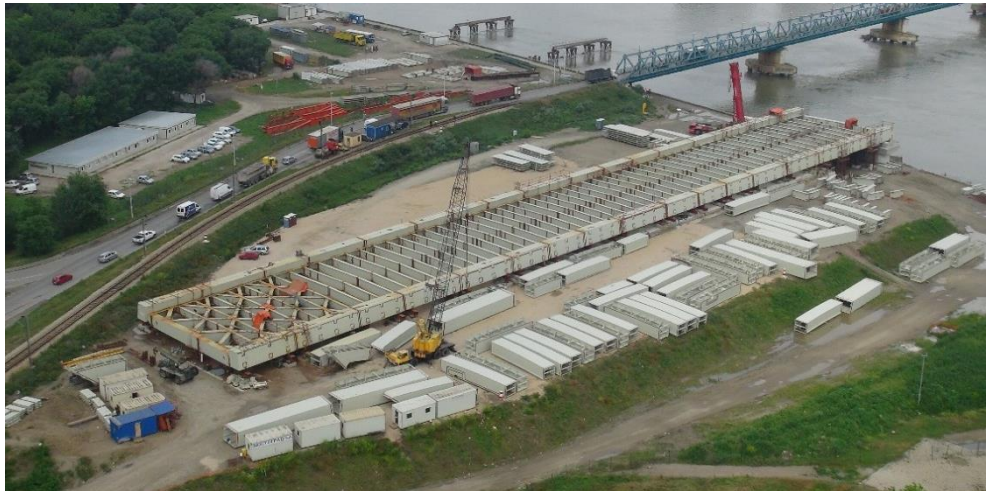
Slika 3 – Donji deo čelične konstrukcije lukova u fazi montaže
