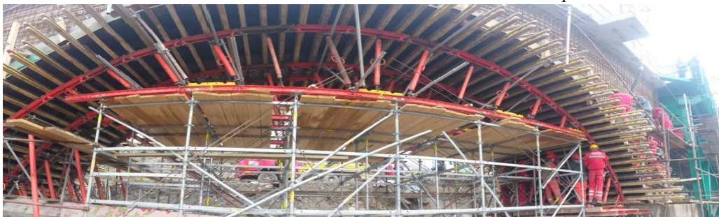
Slika 8–Oplata, skela i armatura novih betonskih lukova i zidova
