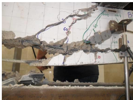
Slika 12 – Odvajanje betona u visini zaštitnog sloja betona
