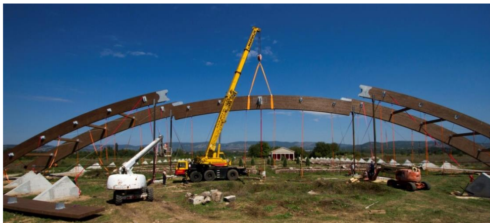
Slika 8 - Predmontaža jednog polja
