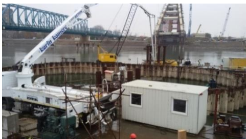
Podvodno betoniranje „čepa“
