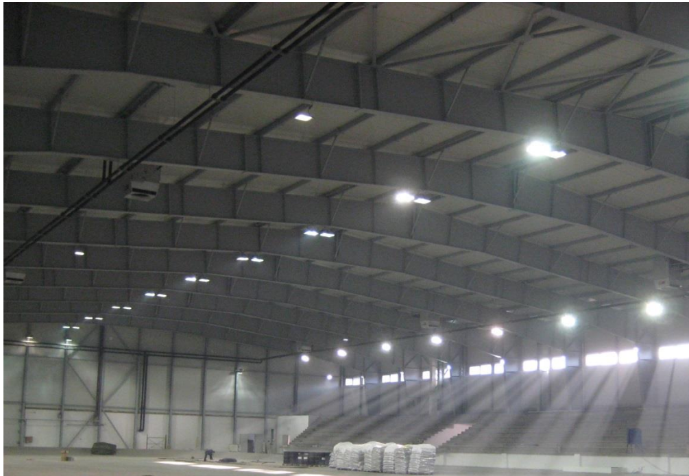
Slika 10 – Izgled konstrukcije neposredno pred završetak radova
