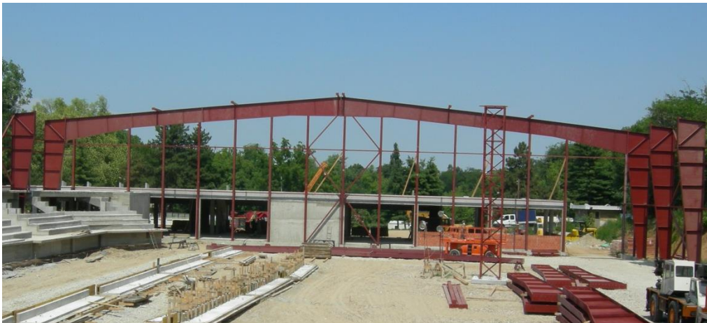
Slika 7 – Montaža kalkanske čelične konstrukcije
