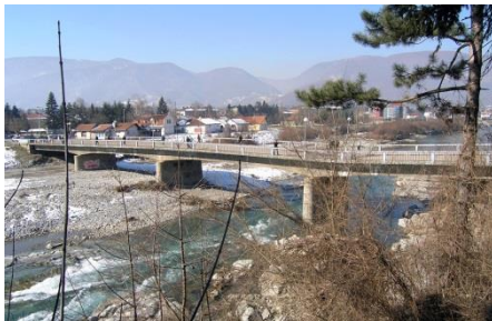
Slika 7. Izgled oštećenog mosta
