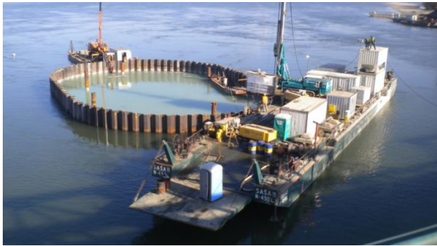
Izrada šipova mlaznim injektiranjem
