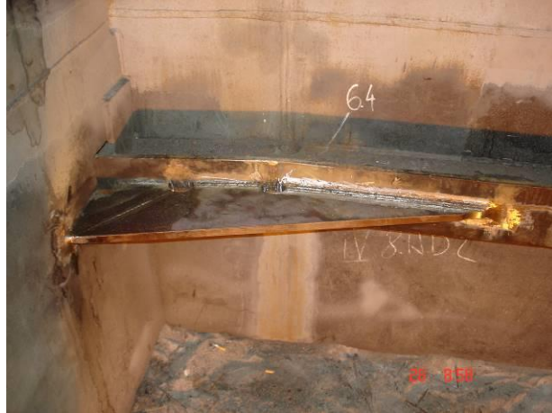
Slika 12 - Radovi na postavljanju i varenju novih limova na mestu sekundarnih nosača
