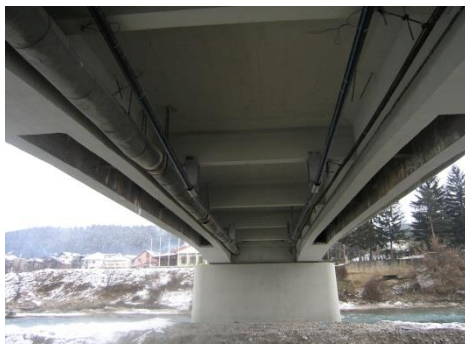
Slika 9. Pogled na most odozdo
