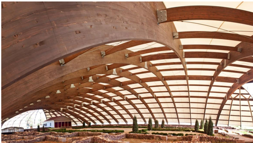
Slika 13- Zaštitna konstrukcija od LLDa
