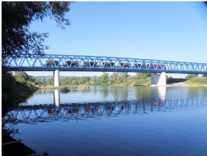
Slika 8 – Probno opterećenje na mostu
