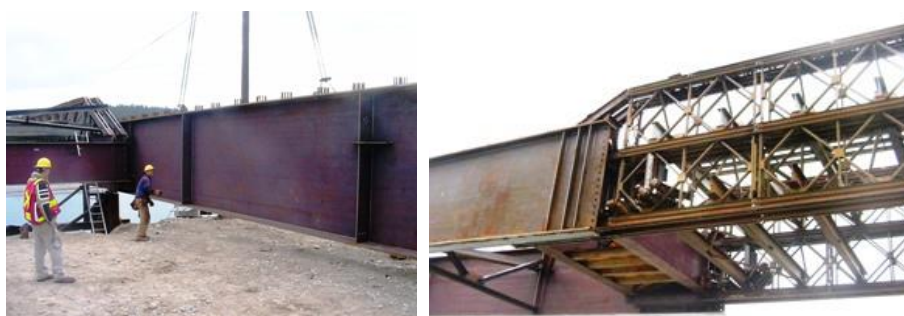
Slika 4.4 Montaža kontinualne veze
