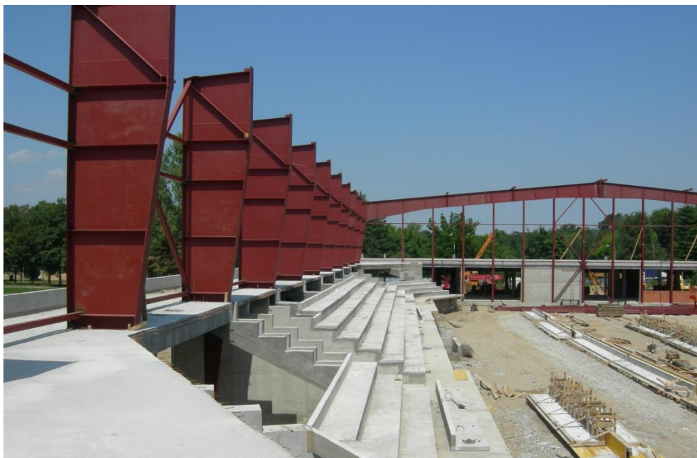
Slika 8 – Montaža glavnih stubova ramovskih nosača na strani tribina
