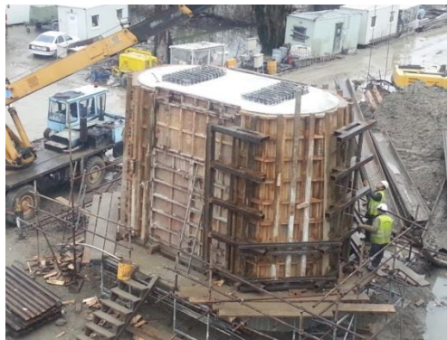
Betonaža II faze stuba S3
