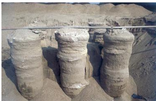
Slika 3 - „Jet grouting“ kolone
