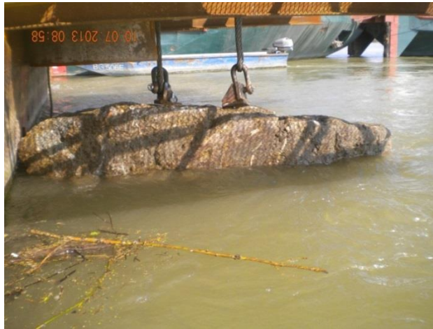
Transport betonskog bloka
