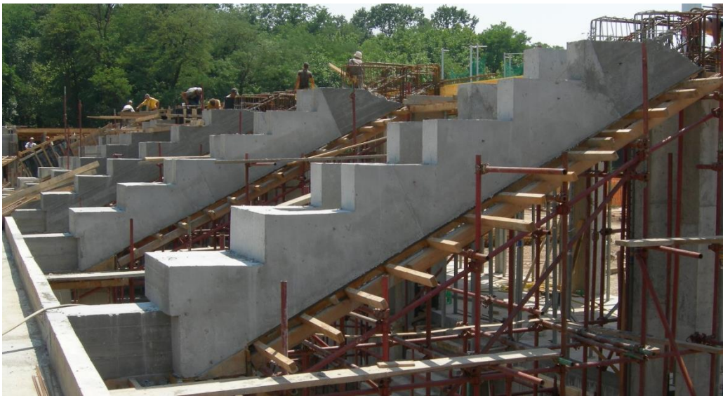
Slika 6 – Tribinski nosači u izgradnji
