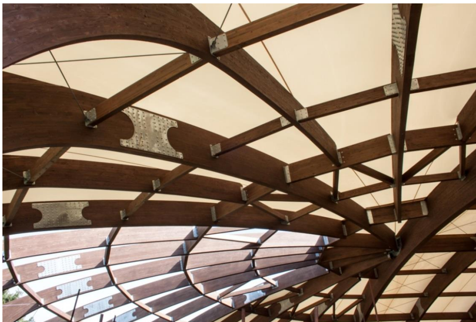
Slika 11- Zaštitna konstrukcija od LLDa
