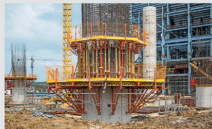
Termoelektrana Stanari, Bosna i Hercegovina
