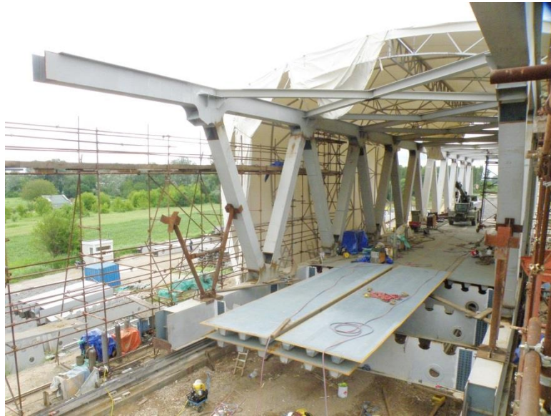
Slika 5 – Uključivanje konstrukcije na stazi
