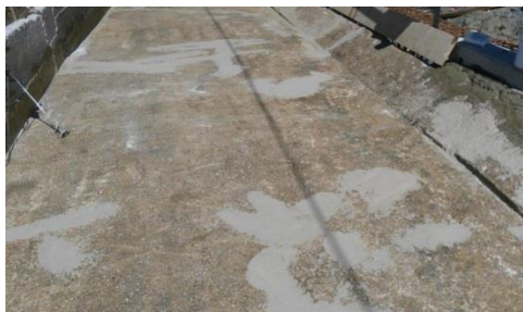
Slika 9–Sanacija oštećenja reparatur malterima i smolama
