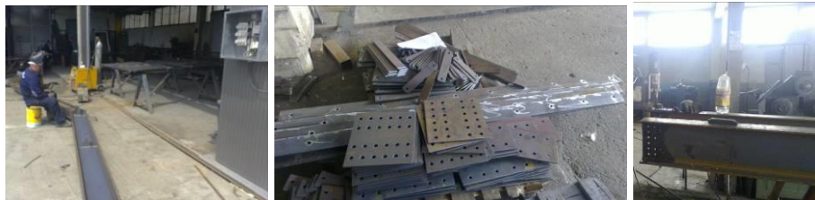
Slika 7- Izrada čelične konstrukcije
