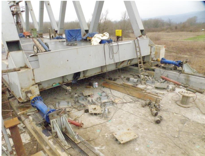
Slika 4 – Oprema za nagurivanje konstrukcije
