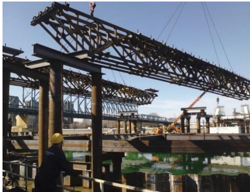
Montaža tipskih rešetki
