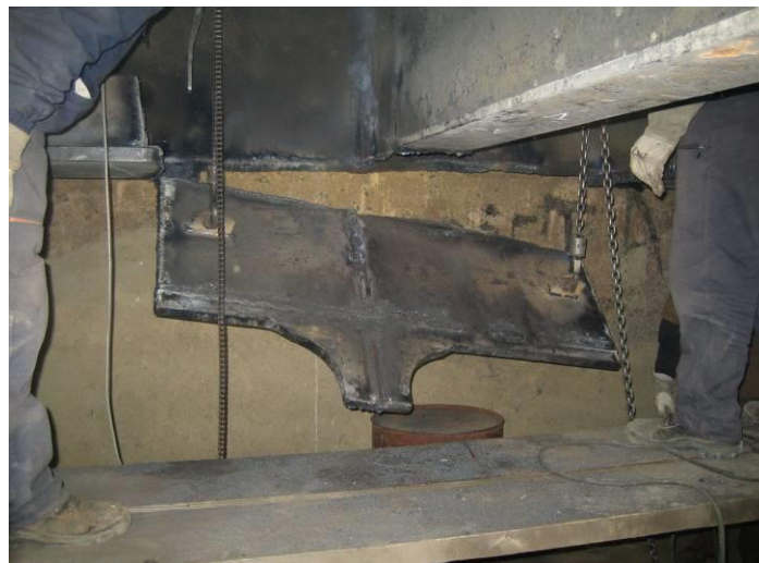
Slika 8 - Radovi na sečenju i uklanjanju dela konstrukcije
