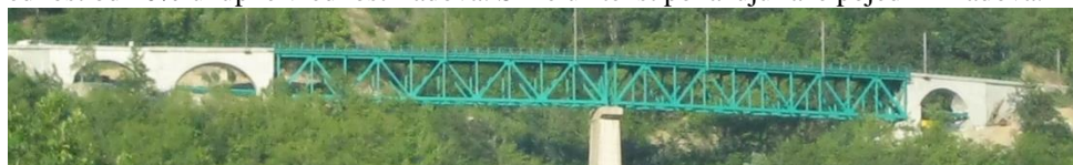
Slika 11 Izgled mosta nakon sprovedenih sanacionih radova (kao zaključak prezentacije)
