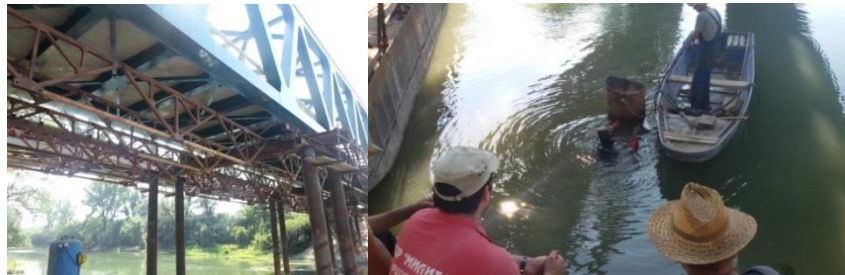
Demontaža jarmova na vodi - Sečenje šipova Ø609
