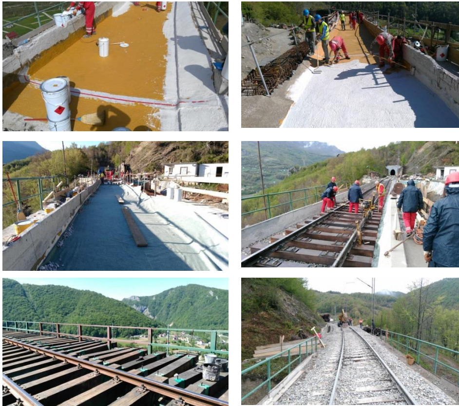
Slika 10 Faze radova na sanaciji i rekonstrukciji gornjeg stroja
