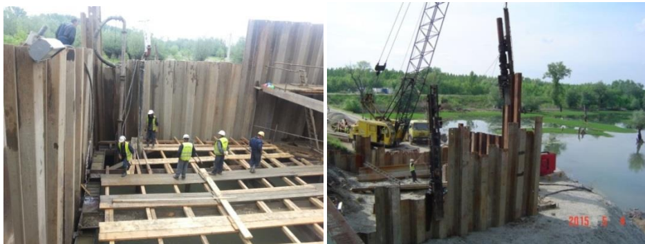
Betoniranje tampon sloja i pobijanje talpi priboja
