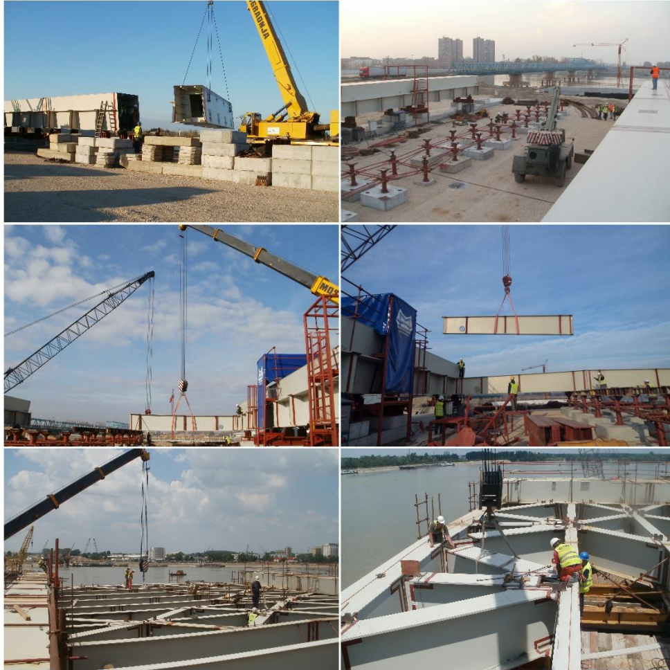
Slika 5 – Montaža elemenata donjeg dela konstrukcije
