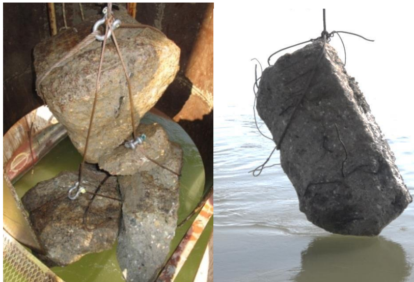
Vađenje manjih betonskih blokova
