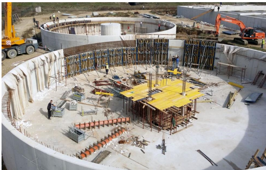
Slika 4 – Kružni rezervoar u fazi izgradnje.
