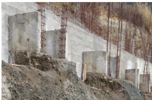
Slika 5 – Detalj izvođenja armiranobetonskih sanduka
