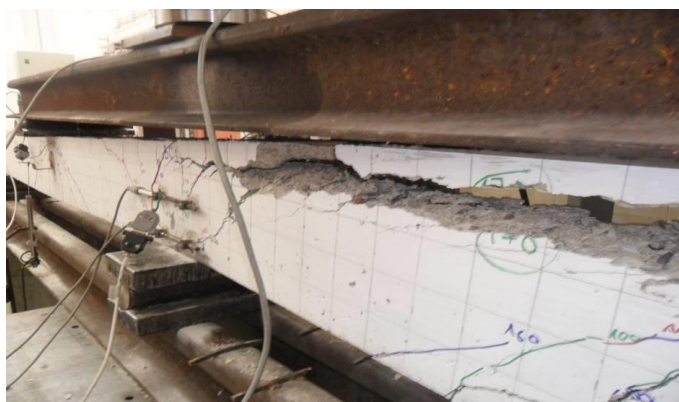
Slika 14 – Otkaz grednog nosača B-C nastao gubitkom prijanjanja CFRP armature
