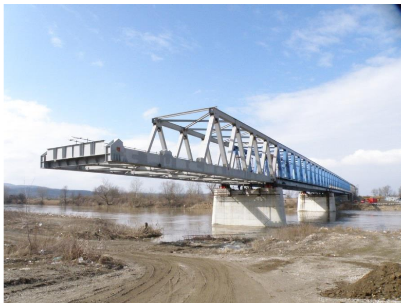
Slika 6 – Izgled "kljuna" prilikom nagurivanja konstrukcije
