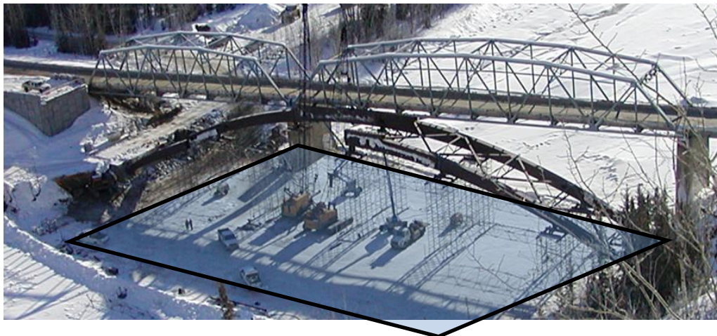
Sl. 1.4 Pogled na gradilište u toku izvođenja lukova mosta
