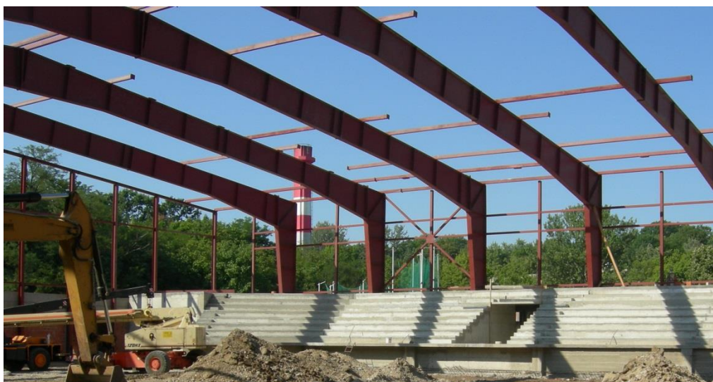
Slika 9 – Montaža glavnih nosača i rožnjača
