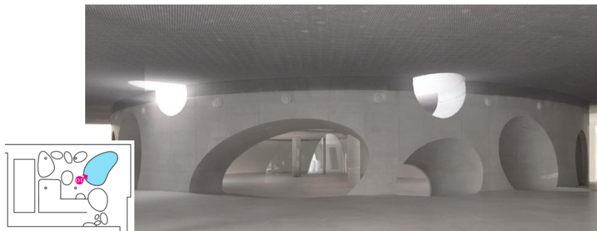
Slika 9 - Izgled jajolikih zidova Podzemlja
