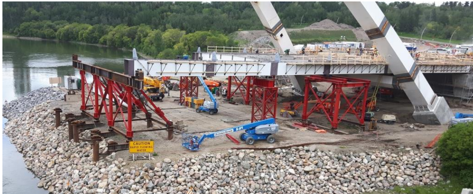
Sl.9 Skela za kolovoznu konstrukciju na nasutom delu
