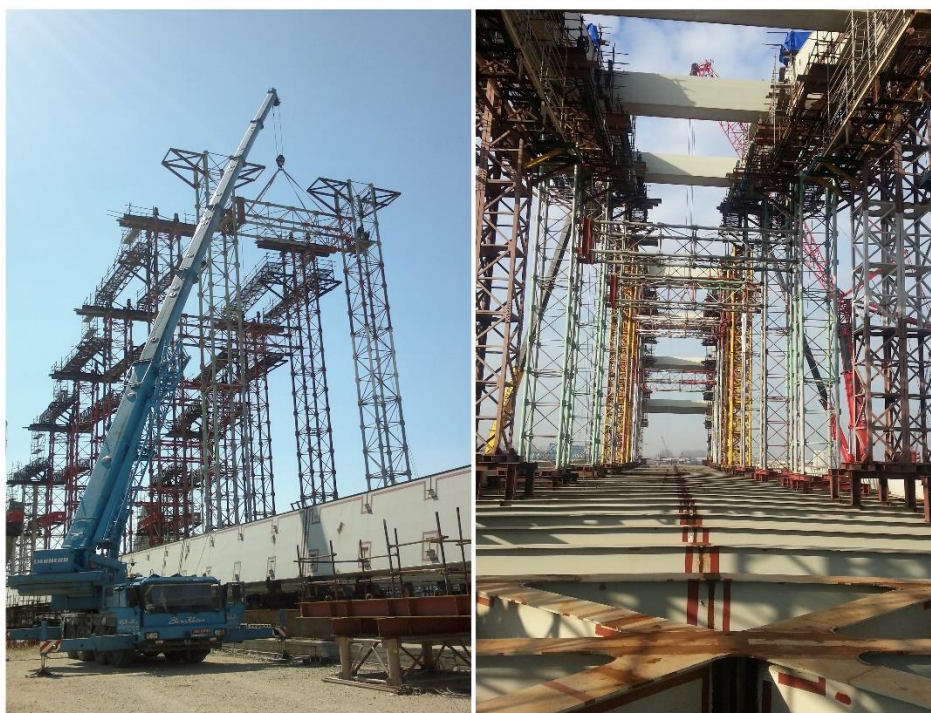
Slika 9 – Pomoćni jarmovi za oslanjanje elemenata lukova u fazi montaže
