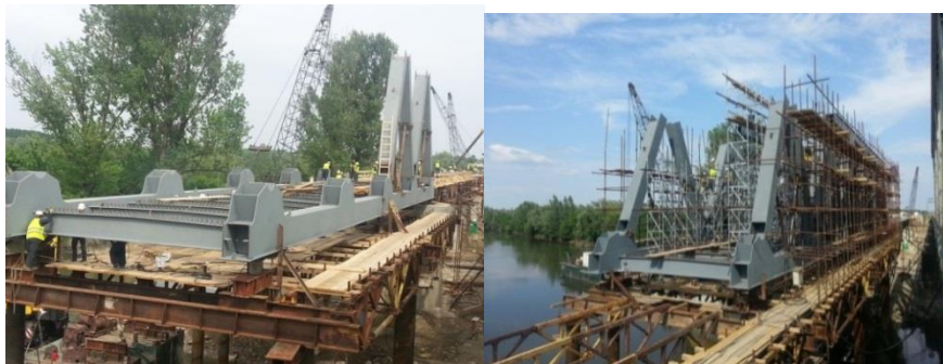
Montaža glavne konstrukcije
