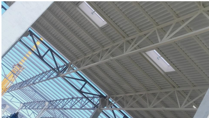
Slika 11 –Parcijalna montaža čelične krovne konstrukcije, trapeznog lima i svetlosnih kupola
