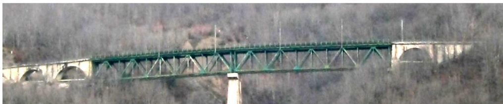
Slika 1 – Most „Trebiljevo“ izgled pre rekonstrukcije (04.12.2014.)
