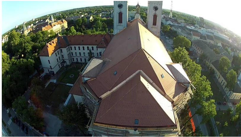
Slika 18 - Snimak gotovog krova snimljen putem drona
