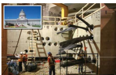
Slika 9 - Izvedba ojačanja na potres na zgradi gradske vijećnice, Utah, SAD [32]
