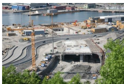
Slika 7 - Bjørvika tunel u gradnji, Oslo, Norveška [30]
