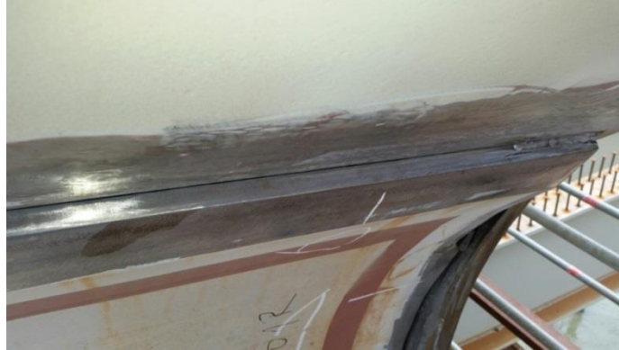
Slika 4. Priprema žleba za zavarivanje
