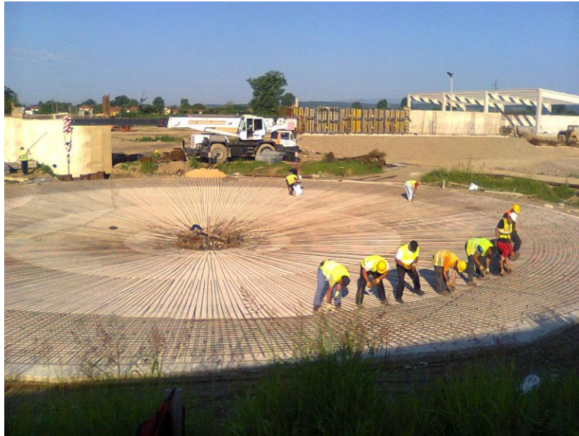
Slika 2 – Armiranje temeljne ploče kružnog rezervoara.
