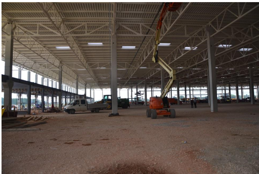
Slika 12 –Krovne rešetke raspona 24 m, rešetkaste podvlake raspona 12 m i spregnuta tavanica sprata na administrativnom delu objekta
