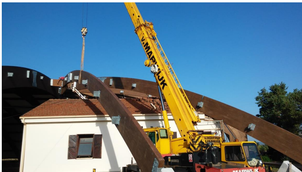
Slika 7 - LLD konstrukcija preko zgrade muzeja
