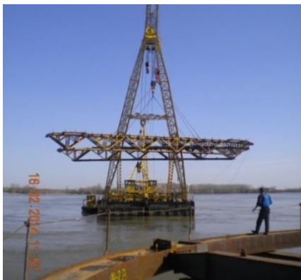
Montaža tipskih rešetki
