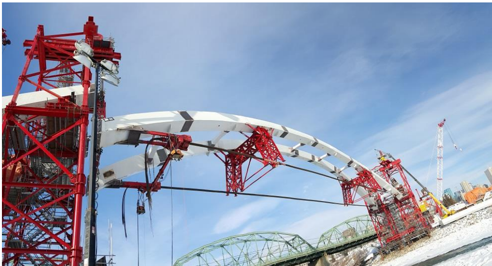
Sl.7 Montaza prvog 88.0 m lucnog segmenta ( 1000t )
