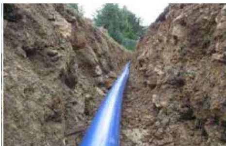
Slika 16. Instalacija HDPE_RC cevi u rov bez posteljice
