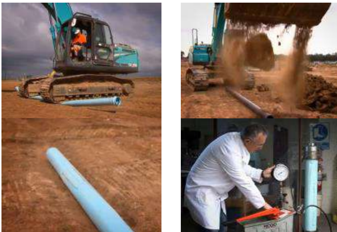
Slika 15. Testiranje PVC-O cevi na mehanička oštećenja
