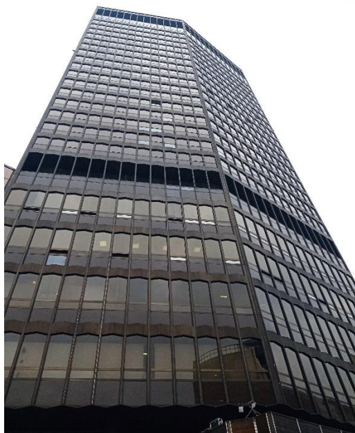
„Београђанка“- (1969-74), висина 101м. Чitava носећа конструкција пројектована је у класично армираном бетону. У време изградње била је највиша зграда на Балкану (фото: Ј.Њ. Поповић)
