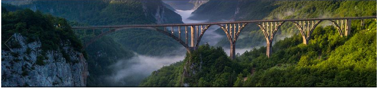
Мост на Ђурђевића Тари (1938/40.), петолучна конструкција, главни лук распона 116 м. (фото: Мирослава Дурцатова)
