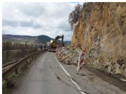
Slika 12. Radovi na čišćenju odrona i sanaciji nestabilnih kosina
