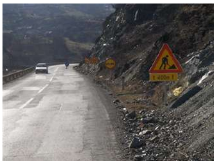
Slika 11. Radovi na čišćenju odrona i sanaciji nestabilnih kosina
