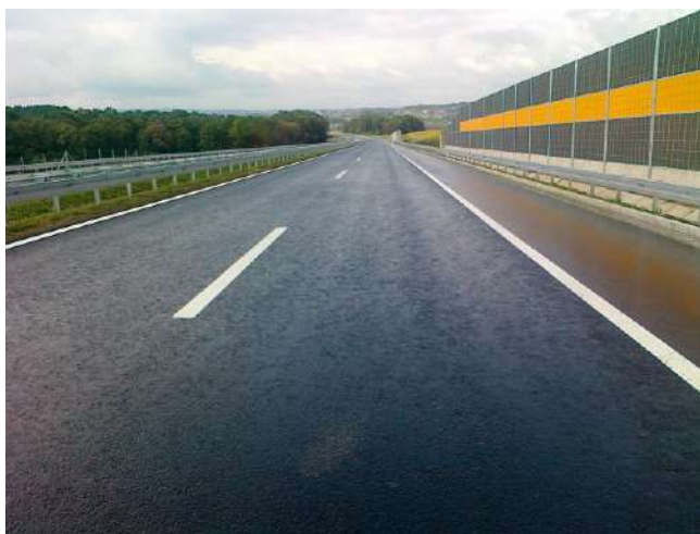
Слика 4. Примјер заштите од буке (Извор: лична фотодокументација са градилишта)
