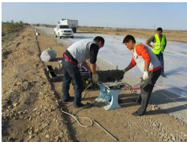
Slika 3 Uzimanje kontrolne gredice na mestu ugradnje
