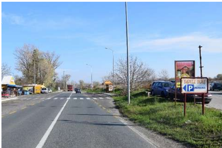
Слика 4. Непостојање саобраћајног знака пешачки прелаз Извор: База података о Дубинским анализама саобраћајних незгода
