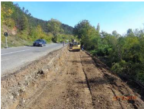
Slika 7. Stepenasti zasek na IB31Raška - Jarinje
