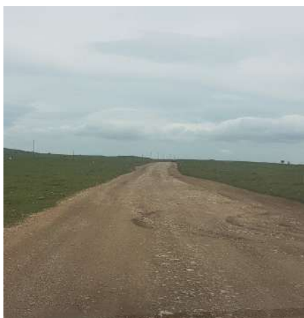
Slika 16. Vododerine na makadamskom putu IIA 197 Slika 17. Vododerine na makadamskom putu IIA 197 Deonica Tuzinje – Karajukića Bunari Deonica Rasno - Tuzinje
