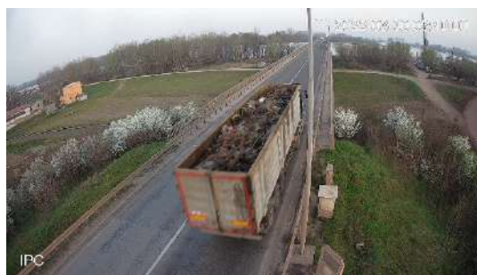
fotografija 3: prikaz vozila sa time stampom koja uzrokuju izmerene poremećaje ubrzanja na središnjoj tački mosta(2022/03/30 05:40, smer Smederevo Kovin)
