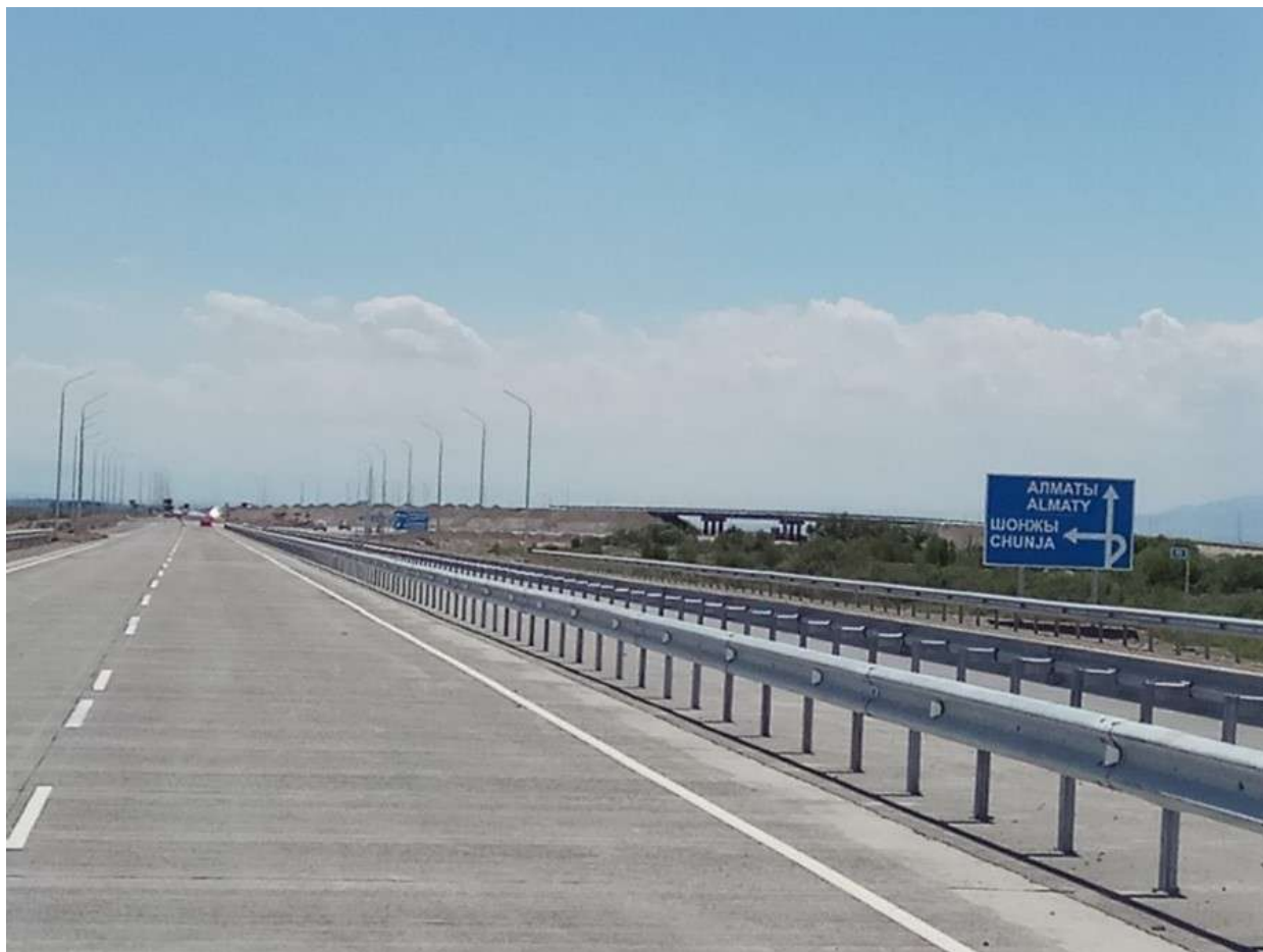
Slika 7 Deonica autoputa sa krutom kolovoznom konstrukcijom u završnoj fazi građenja
