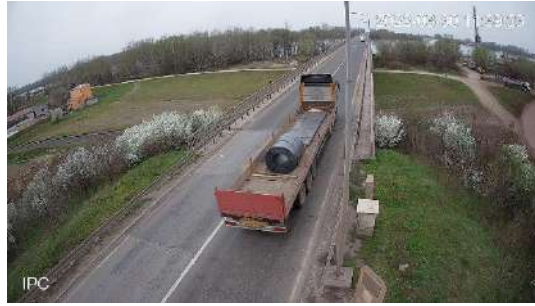
fotografija 5: prikaz vozila sa time stampom koja uzrokuju izmerene poremećaje ubrzanja na središnjoj tački mosta(2022/03/30 11:39, smer Smederevo Kovin)
