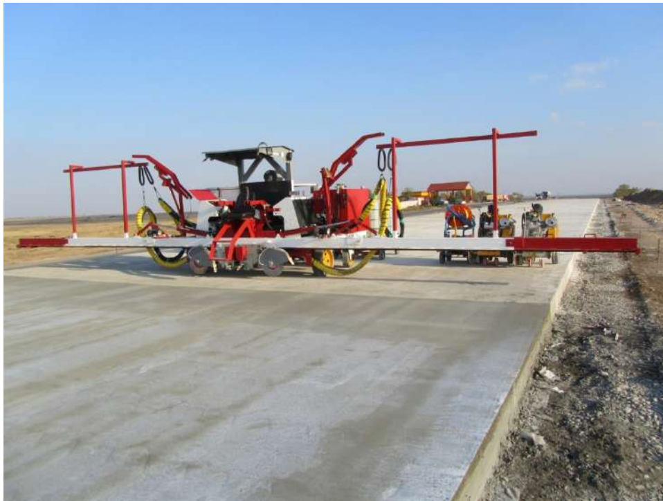
Slika 6 Komplet opreme za urezivanje spojnica, poprečnih i podužnih
