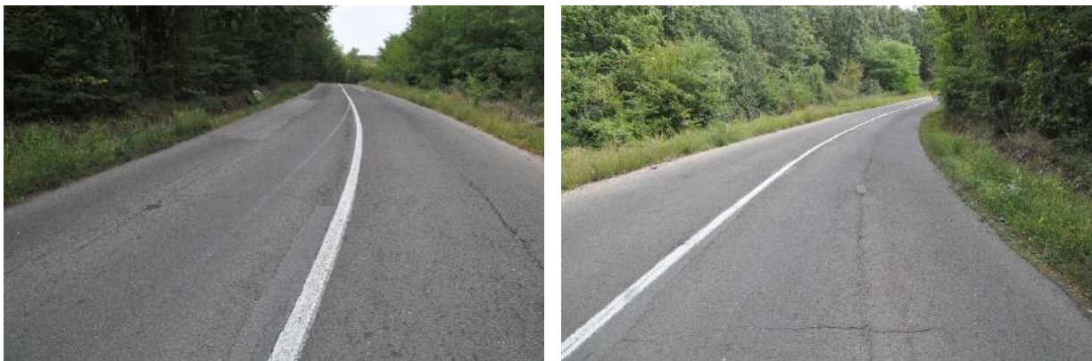
Slike 10 i 11. – Kombinacija horizontalnih i vertikalnih krivina
