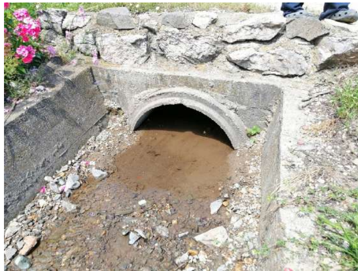
Slika 4. Propust zasut nanosom na potoku Jagnjilo na deonici Jasikovo-Žagubica Source: (Izvor, Cmyđuja, 2020)
