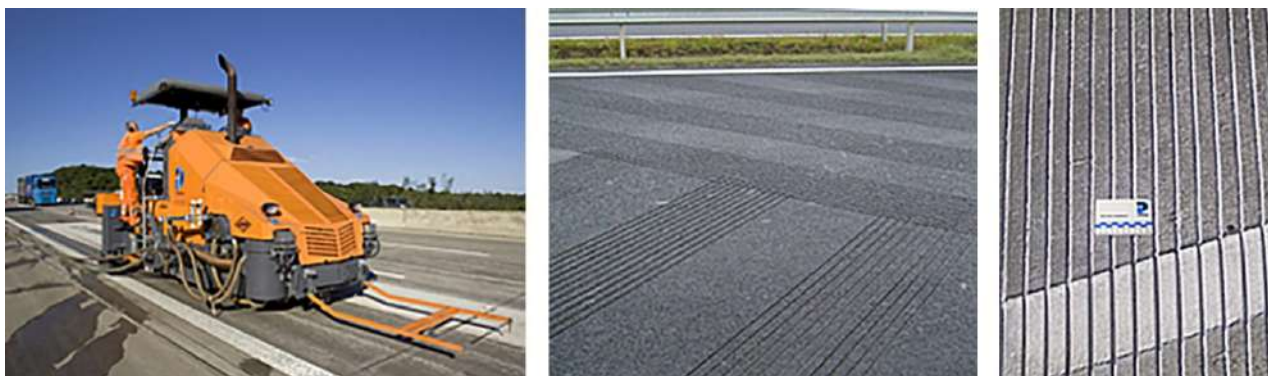
Slika 13. Žlebljenje asfaltno kolovozne površine usecanjem uskih brazdi specijalnim mašinama (Izvor: [12])
