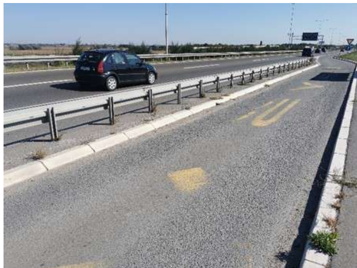
Slika 5. Problematična trajektorija uliva u osnovni tok autoputa (Izvor: [4])
