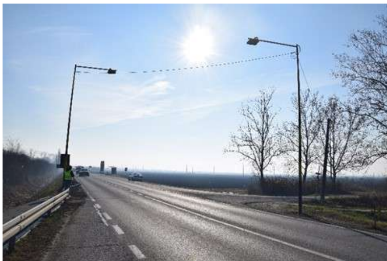
Слика 3. Непостојање хоризонталних ознака пешачког прелаза Извор: База података о Дубинским анализама саобраћајних незгода
