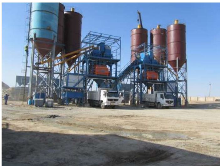
Slika 2 Dve spregnute fabrike betona u radu
