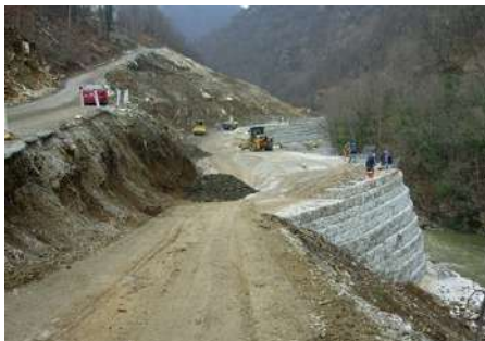
Slika 9. Sanacija klizišta na IB30 Ivanjica - Ušće
