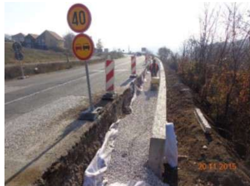
Slika 8. Izrada potpornog zida na IB31Raška - Jarinje
