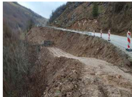
Slika 10. Pristupni put za zid na IB29 Aljinoviće - Sjenica
