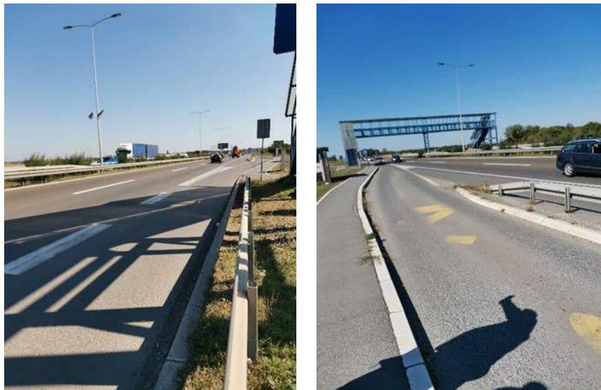
Slika 5. Konflikt ulivna traka/niša za zaustavljanje vozila (Izvor:[4])
