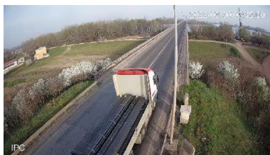
fotografija 4: prikaz vozila sa time stampom koja uzrokuju izmerene poremećaje ubrzanja na središnjoj tački mosta(2022/03/30 06:45, smer Smederevo Kovin)
