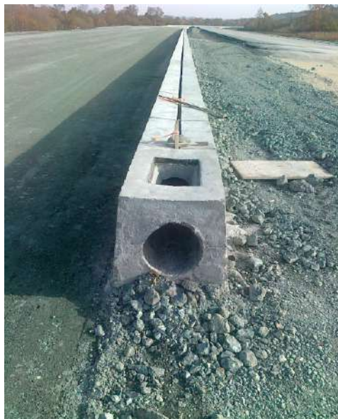
Слика 3. Просјечена бетонска цијев (Извор: лична фотодокументација са градилишта)
