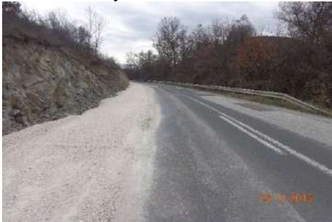
Slika 5. Proširenje kolovoza na IB 31 Raška – Jarinje
