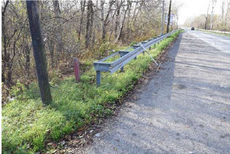
Слика 2. Пасивно небезбедан завршетак заштитне ограде Извор: База података о Дубинским анализама саобраћајних незгода
