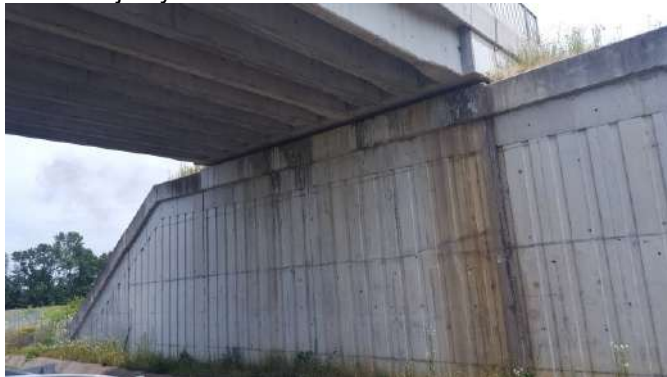
Слика 2. Цурење кроз оштећену дилатацију (Извор: лична фотидокументација са градилишта)
