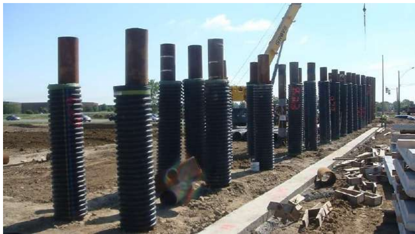
Slika 5. Navlake koje se postavljaju na šipove kako bi se redukovalo negativno trenje duž omotača šipa ( https://civildigital.com/wp-content/uploads/2016/05/PILE-SLEEVES-REDUCE-NEGATIVE-SKIN-FRICTION.jpg )
