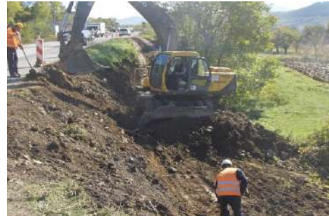
Slika 6. Izrada stepenastog zaseka na IB 31 Raška - Jarinje
