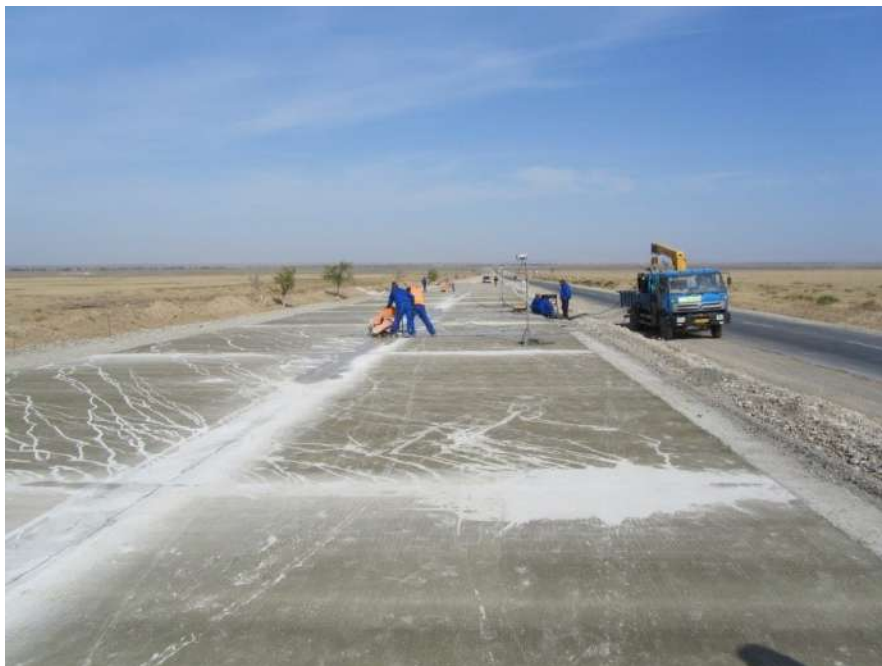
Slika 5 Urezivanje spojnica posle 8-10h, testerama sa dijamantskim diskovima
