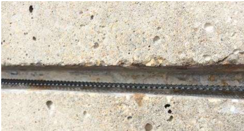
Slika 8 - MMO trakasta anoda postavljena u posečen žljeb pre ugradnje maltera Source: (Izvor, https://www.vector-corrosion.com/lida-mmo-titanium-anodes )
