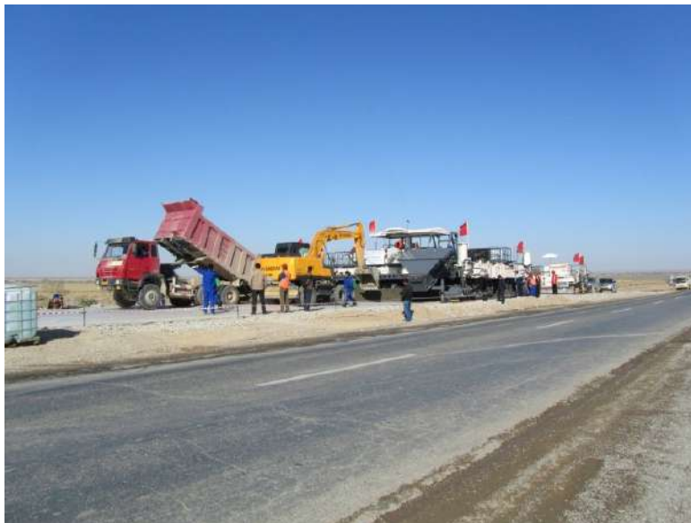
Slika 4 Kompletna garnitura za izradu betonskog zastora na startu. Dovoz betona, kamion sa otvorenom karoserijom, finišer širine 11m, prskalica za kjurung, oprema za urezivanje spojnica
