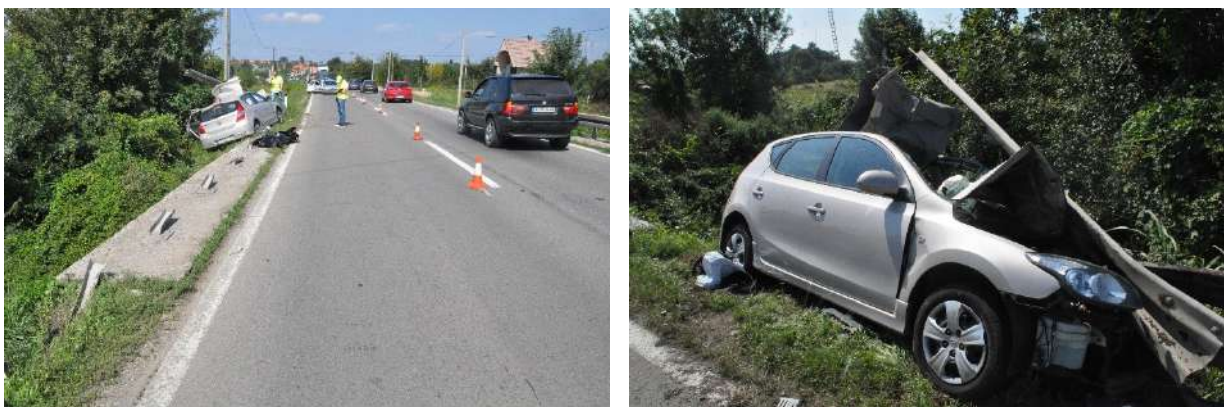
Slike 18 i 19. – Završetak zaštitne ograde
